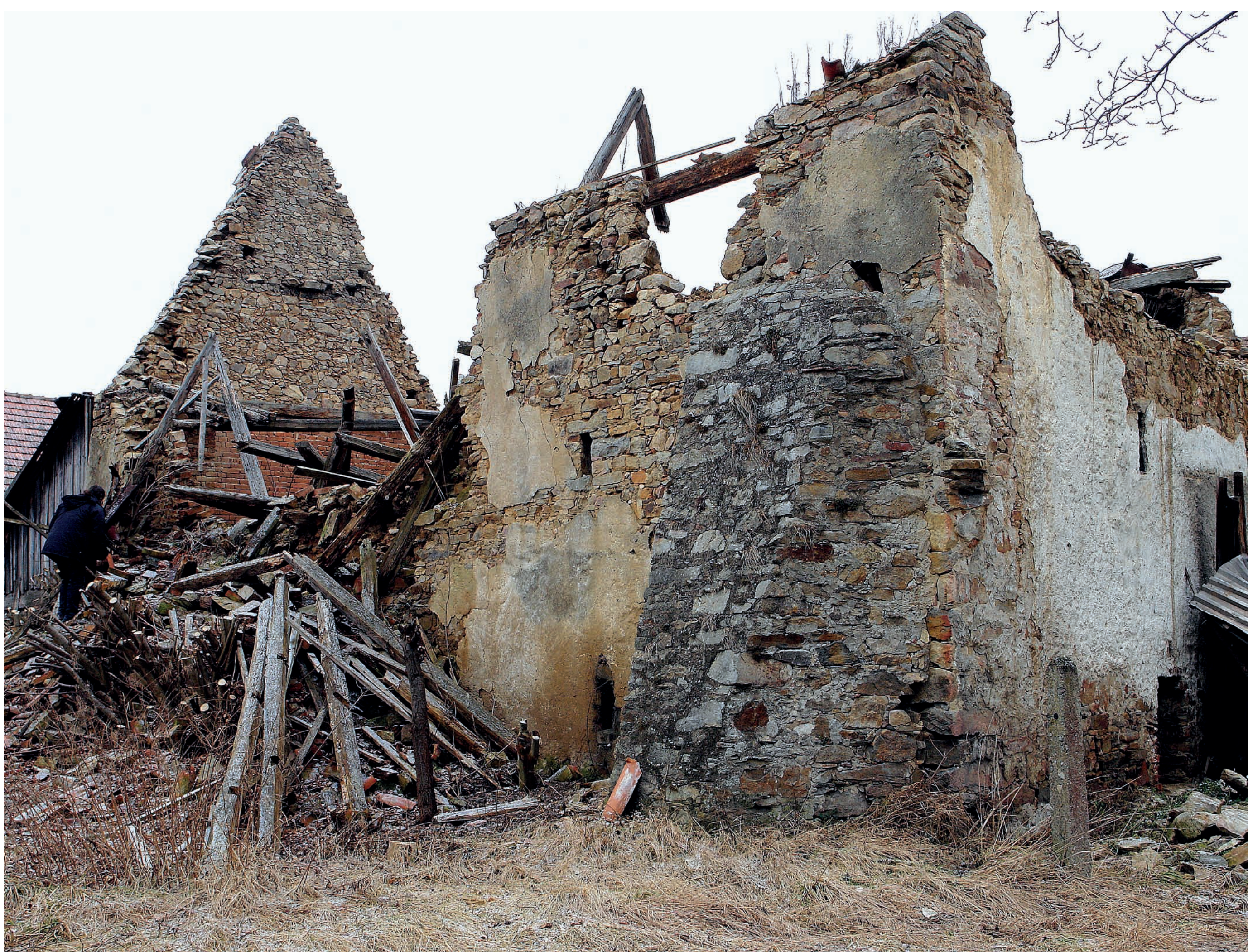
← Stav objektu v kulminačním období destrukcí – po zřícení jižního štítu (vpravo) a části západní stěny. JŠ 2013
