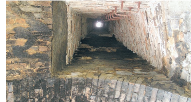
↓ Volfartice (Česká Lípa) čp.195. Pohled vzhůru do dymníkového ústí komína černé kuchyně v někdejší tvrzí. JŠ2008
