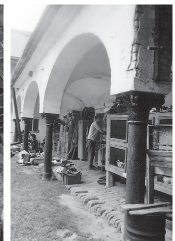
↖↗↘↙ Rychnov (Moravská Třebová) čp. 137. Převážně roubený dům usedlosti z r. 1787. JŠ 1992 ↑ V točnici sklopná okenice v síni staršího domu. JŠ 1992 ↖↖ Monogram FG a vročení 1797 na trámu podstaje. JŠ 1992 ↖↖ Arkádové náspí chlévů s litinovými sloupky u mladšího domu usedlosti z r. 1877. JŠ 1992 ↖↖ Janovice (Česká Lípa). Plackové kleby. JŠ 1978 ↗ Zechovice (Volyně). Severní fronta usedlosti. Zleva čp. 7, čp. 8, čp. 9 a kaplička. SV → Sudkův Důl (Pacov) čp. 10. Usedlost s pozdně gotickou tvrzí. JŠ 2005
