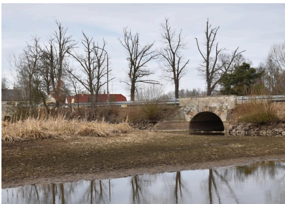
6. KP – pohled na násep se stromořadím a středovým kamenným klenutým mostem z pol. 19. stol.
