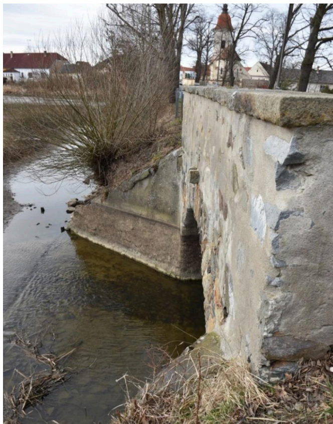
5. KP – pohled na postranní kamenný klenutý most z pol. 19. stol.
