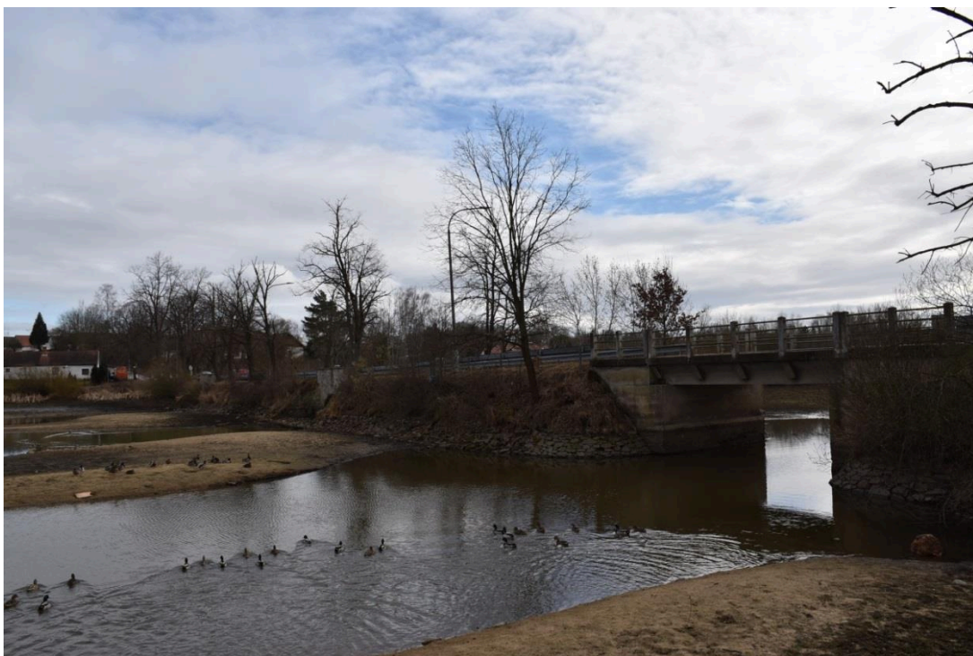
8. KP – pohled na násep se stromořadím a železobetonovým mostem z roku 1927
