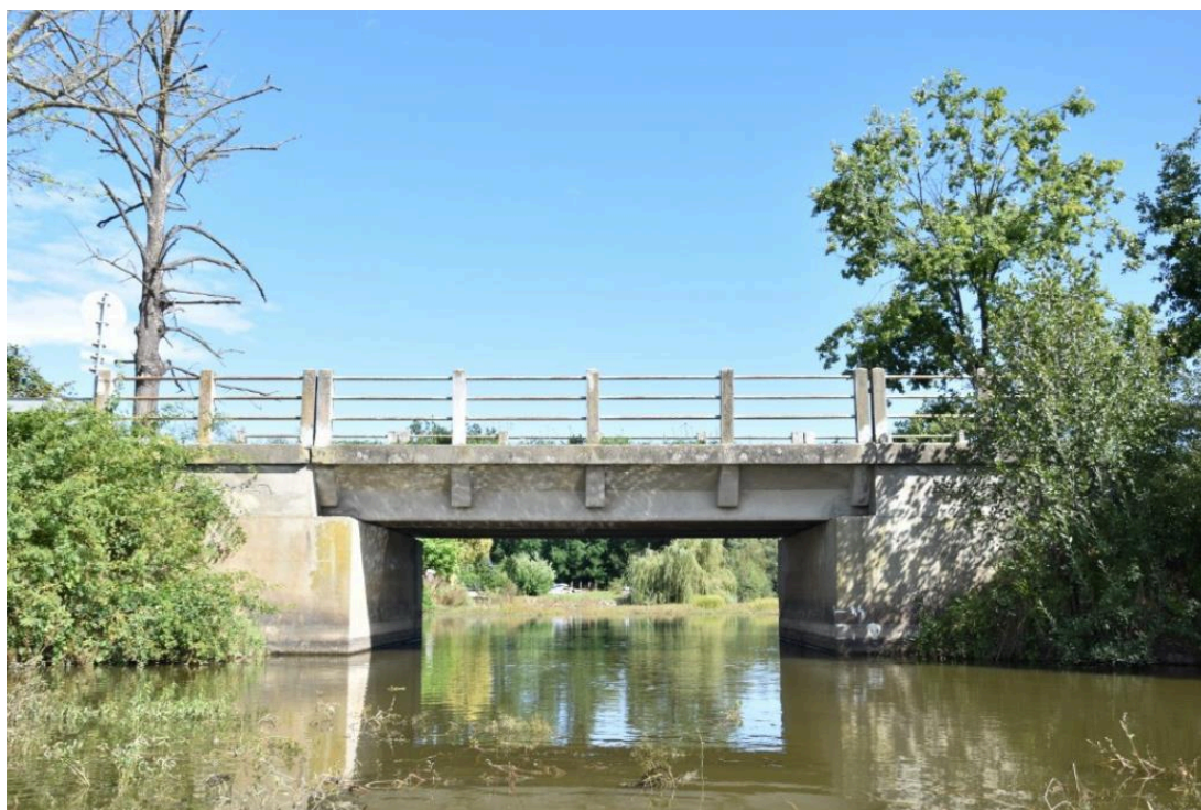
3. KP – pohled na železobetonový most z roku 1927
