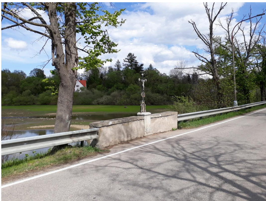
10. KP – pohled na litinový křížek ze silnice vedoucí přes mosty
