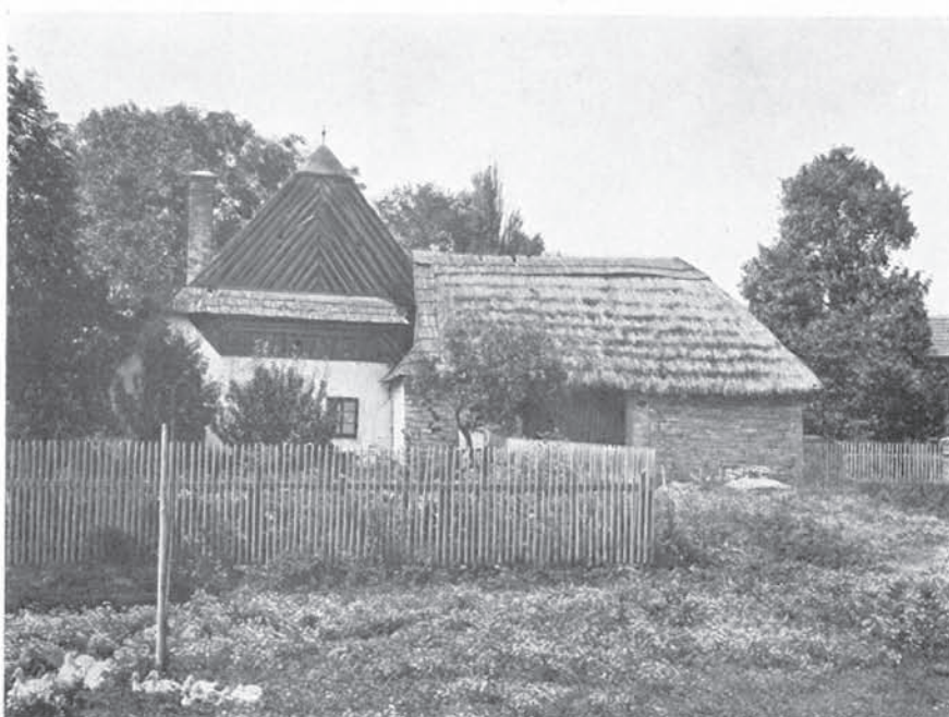
146. SEDLIŠTĚ (LITOMYŠL). Chalupa. — Maison de paysan. — Bauernhaus. — Cottage.
