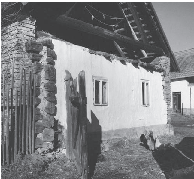
↑ Čičenice u Vodňan čp. 14 – jednoduché, archaické provedení nároží roubené světnice domu s kuláčovými přesahy v celé výšce stěny (JŠ 1975).
