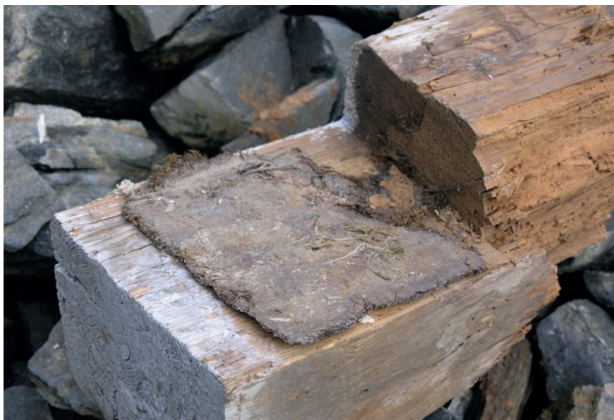
↑ Eš u Pacova čp. 20 – mekhová vložka, nalezená v rybinových vazbách při rekonstrukci roubené světnice chalupy (JŠ 2004).
