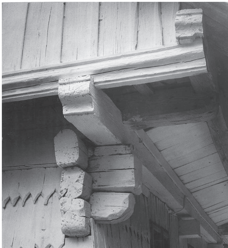
← Ukázka náročnějšího, výzdobného provedení detailů tesařské práce na průčelí roubeného šumavského domu v Chalupách (Stachy čp. 190). Tvarování se týkalo přesahujících trámových konců a také vodorovných římsových prvků – zejména trámu, vynášejícího bedněný štít (JŠ 1975).
