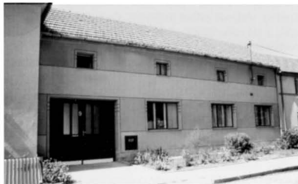
Usedlost čp. 9 – uliční průčelí. Foto 1997.
