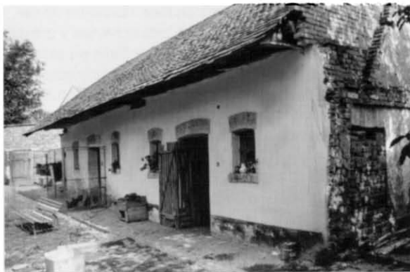
Chlévové křídlo usedlosti čp. 26. Foto 1997.
