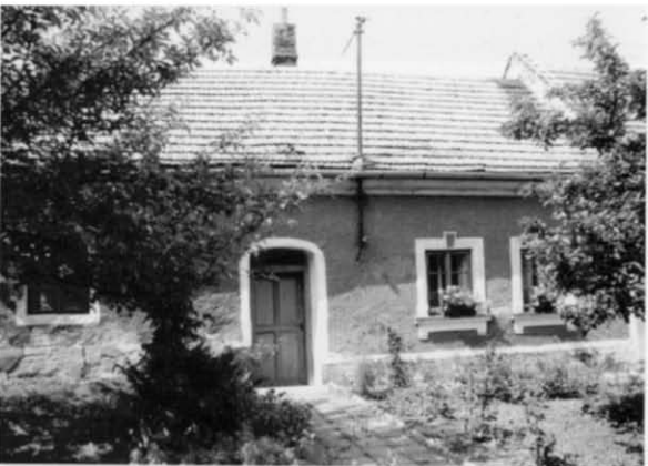
Chalupa čp. 63 – uliční průčelí. Foto 1997.
