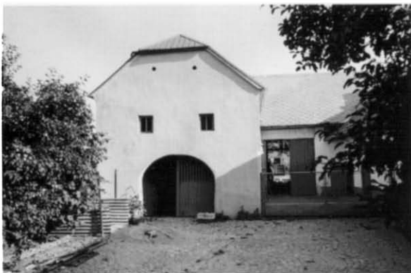
Podélně průjezdná kolna usedlosti čp. 41. Foto 1997.
