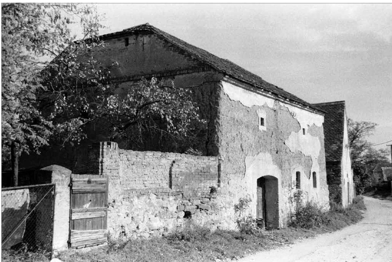
Obr. 4) Lisovna se stěnami z masivní vrstvené nepálené hlíny v Šatově, okr. Znojmo (foto Z. Syrová 1995).
