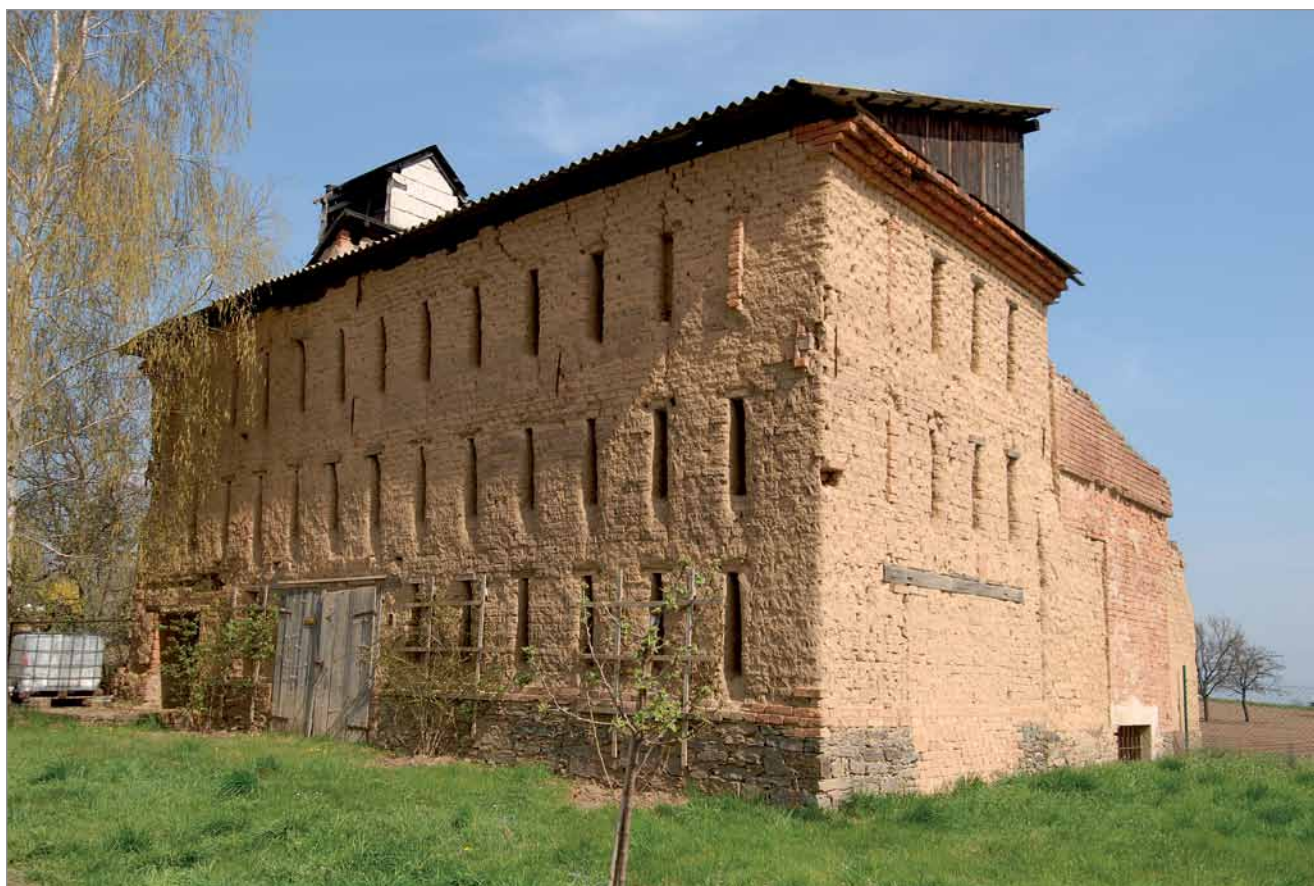
Obr. 1) Sušírna chmele usedlosti čp. 4 v Odrlicích zděná z nepálených cihel s kamennou podezdívkou a římsou z pálených cihel, okr. Olomouc (foto Z. Syrová 2008).
