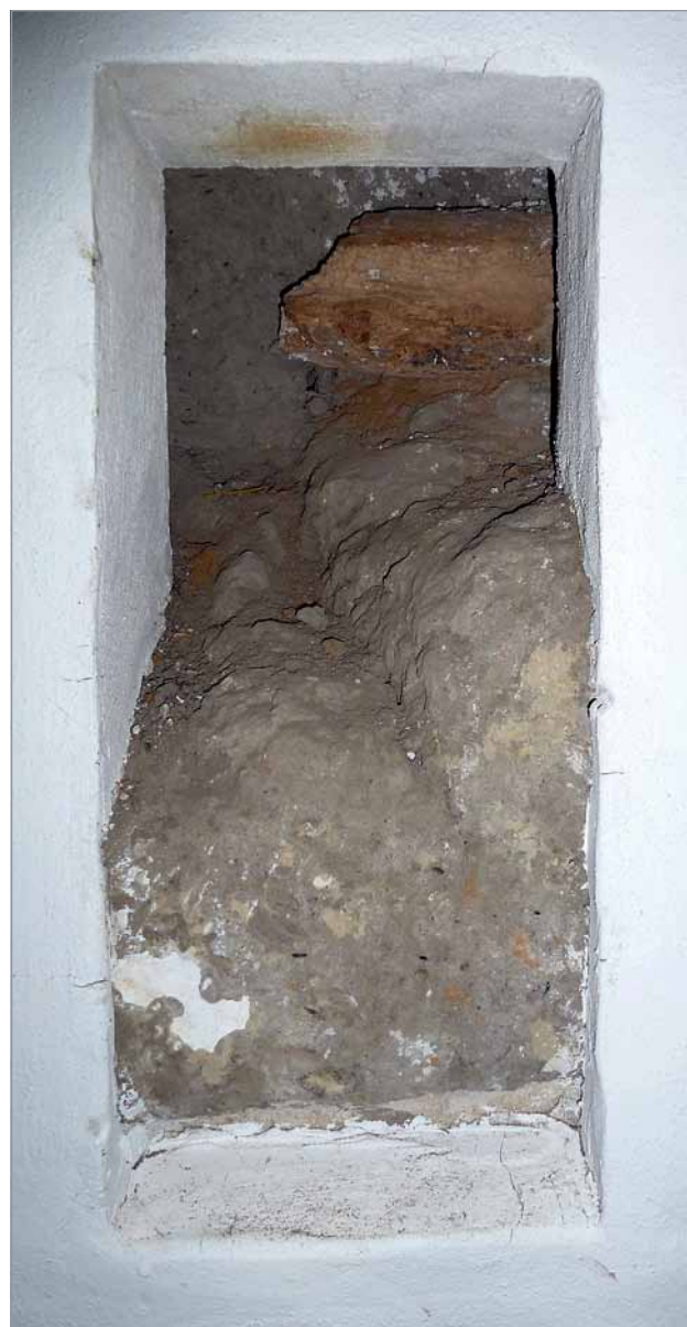
Obr. 9) Detail stěny z masivní hlíny komory domu čp. 115 v Pouzdřanech, okr. Břeclav (foto Z. Syrová 2014).
