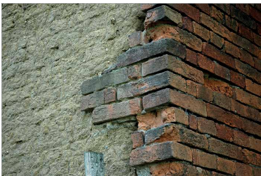
Obr. 11) Detail nároží s obkladem z pálených cihel z oblasti Hané, Rataje, okr. Olomouc (foto Z. Syrová 2005).
