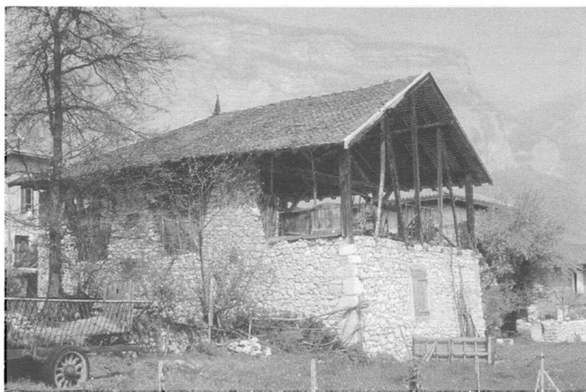
Obr. 12. Bernin, Isère, Francie; seníkové patro s vaznicemi podepřenými dřevěnými vzpěrami a podezděním. Foto Z. Syrová, 1991. – Abb. 12. Bernin, Isère, Frankreich; Heubodengeschoß mit Pfetten, die von Holzstreben und Untermauerung getragen werden. Foto Z. Syrová, 1991.
