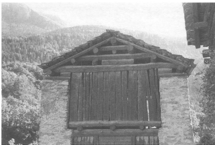
Obr. 4. Villa di Chivenna, Itálie; konstrukce střechy seníku nad chlévem s volně vrstvenými kuláči štítů a vaznicemi. Foto Z. Syrová, 2000. – Abb. 4. Villa di Chivenna, Italien; Dachkonstruktion eines Heubodens über einem Stall mit Pfetten und mit Giebeln aus lose geschichteten Rundhölzern. Foto Z. Syrová, 2000.
