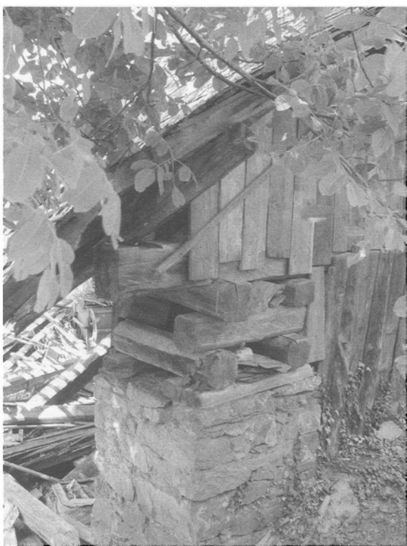
Obr. 9. Le Châtel, l'Echaillon, Savoie, Francie; pružné podepření krovu hraničkami trámů. Foto Z. Syrová, 2001. – Abb. 9. Le Châtel, l'Echaillon, Savoyen, Frankreich; mit Stapeln aus kleinen Balken ausgeführte elastische Auflagerung des Dachwerks. Foto Z. Syrová, 2001.
