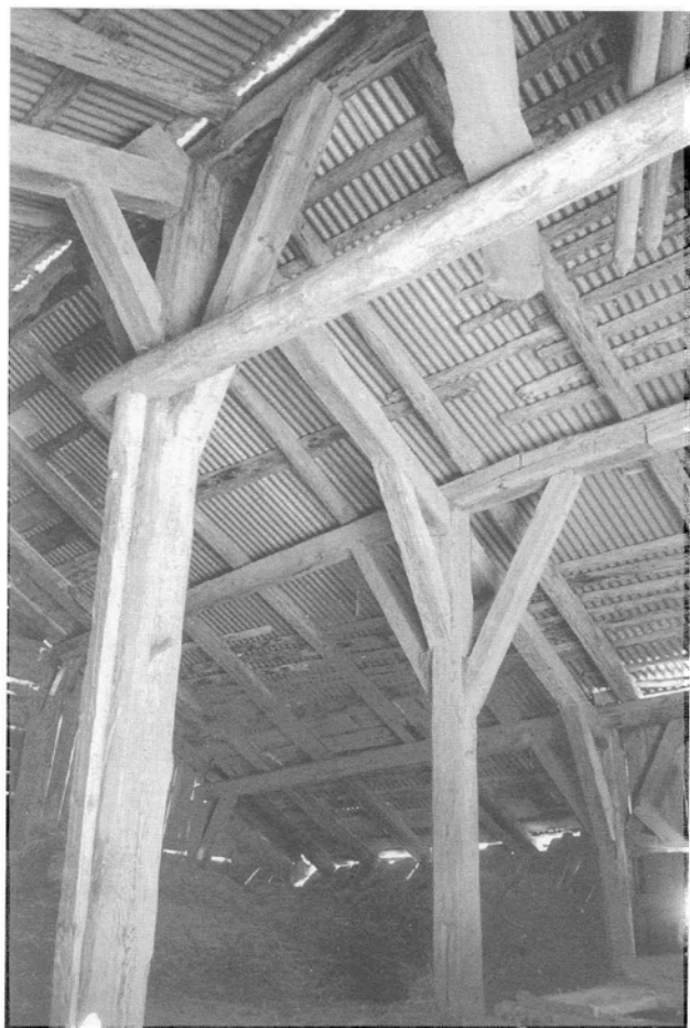
Obr. 18. Abondance, le Crêt, Haute-Savoie, Francie; sloupová konstrukce krovu na principu pointe d'âne . Foto Z. Syrová 2000. – Abb. 18. Abondance, le Crêt, Haute-Savoyen, Frankreich; Säulenkonstruktion des Dachwerks nach dem Prinzip pointe d'âne . Foto Z. Syrová, 2000.
