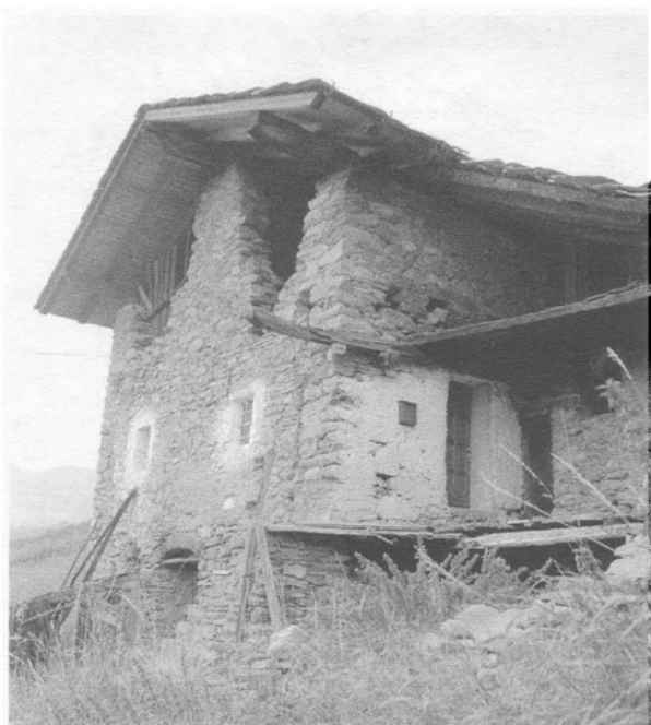
Obr. 10. Verrayes, Del, Itálie; dům se seníkovým podstřeším s podezděnými vaznicemi. Foto Z. Syrová, 2000. – Abb. 10. Verrayes, Del, Italien; Haus mit Heuboden mit untermauerten Pfetten. Foto Z. Syrová, 2000.
