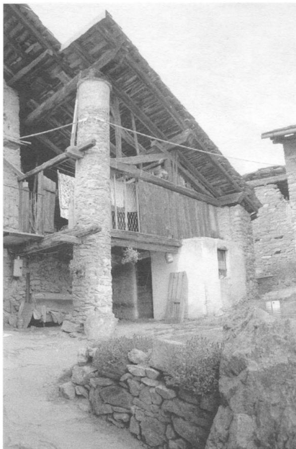
Obr. 11. Verrayes, Del, Itálie, podpora vaznic sloupem a nůžkovou konstrukcí. Foto Z. Syrová, 2000. – Abb. 11. Verrayes, Del, Italien; Unterstützung der Pfetten mit Säule und Scherenkonstruktion. Foto Z. Syrová, 2000.
