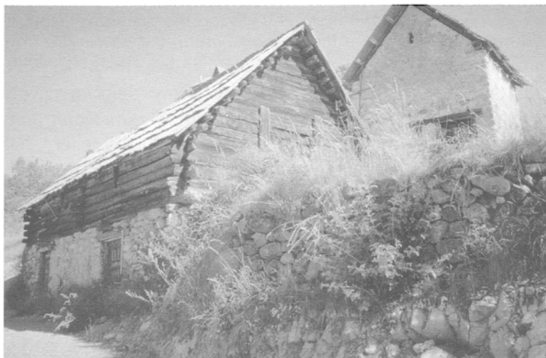
Obr. 1. Beuil, Alpes-Maritimes, Francie; roubený seník nad chlévem se zaroubenými vazničkami nesoucími přímo krytinu. Foto Z. Syrová, 1998. – Abb. 1. Beuil, Alpes-Maritimes, Frankreich; in Blockbauweise ausgeführter Heuboden über einem Stall mit verzimmerten kleinen Pfetten, auf denen die Dachdeckung direkt aufliegt. Foto Z. Syrová, 1998.
