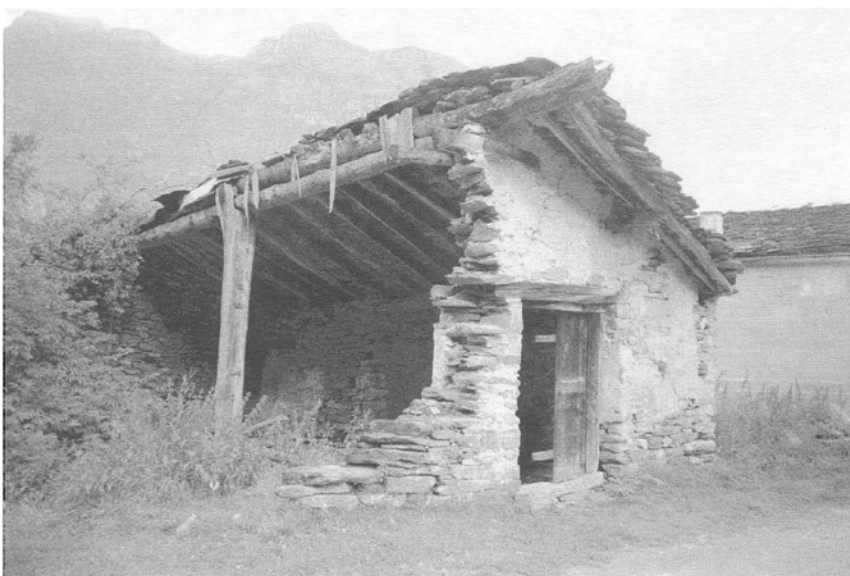
Obr. 15. Bessans, le Villaron, Savoie, Francie; torzo poloviny kamenného domu s hřebenovou vaznicí spočívající na štítových stěnách a středním rozvidleném sloupu. Foto Z. Syrová, 2000. – Abb. 15. Bessans, le Villaron, Savoyen, Frankreich; Torso der Hälfte eines Steinhauses mit Firstpfette, die auf den Giebelwänden ruht, und mit gegabelter Mittelsäule. Foto Z. Syrová, 2000.
