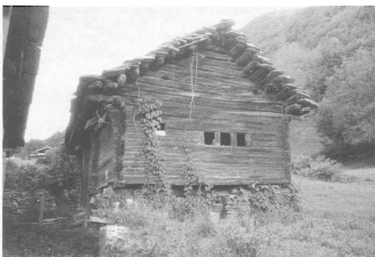
Obr. 5. Aquila, Ticino, Švýcarsko; obytný dům ze 16. století se zaroubenými vaznicemi a vazničkami. Foto Z. Syrová, 1996. – Abb. 5. Aquila, Ticino, Schweiz; Wohnhaus aus dem 16. Jahrhundert mit verzimmerten Hauptpfetten und kleinen Nebensepfetten. Foto Z. Syrová, 1996.
