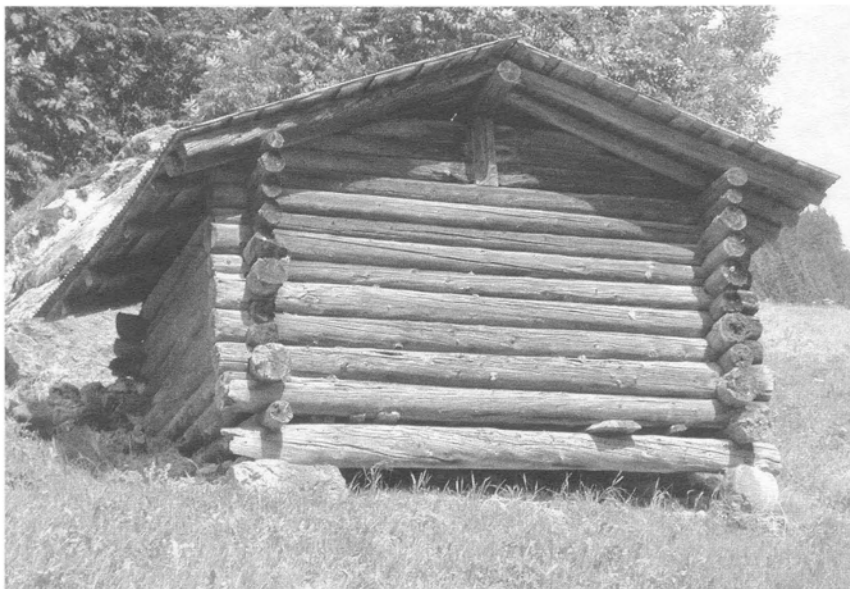
Obr. 13. L'Etivaz, la Guerche; Vaud, Švýcarsko, drobný seník roubený z kuláčů se zkráceným sloupkem pod hřebenovou vaznicí ve štítě. Foto Z. Syrová, 2003. – Abb. 13. L'Etivaz, la Guerche; Vaud, Schweiz; kleiner Heustadel, aus Rundholz gezimmert, mit verkürzter Säule unter der Firstpfette im Giebel. Foto Z. Syrová, 2003.
