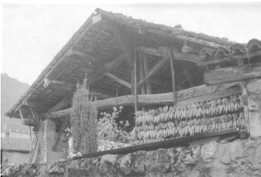
Obr. 14. Le Touvet, Isère, Francie; „klasický“ krov s „vazbou“ a vaznicemi. Foto Z. Syrová, 1991. – Abb. 14. Le Touvet, Isère, Frankreich; „klassisches“ Dachwerk mit „Bindern“ und Pfetten. Z. Syrová, 1991.
