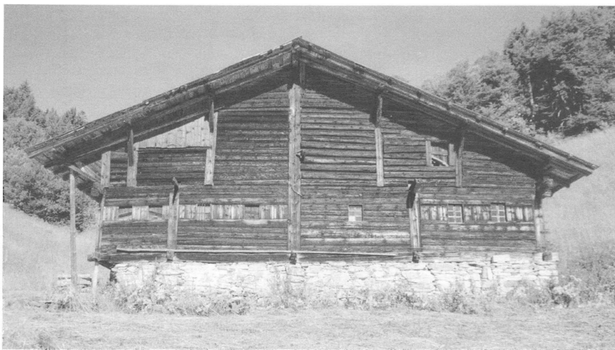
Obr. 17. Abondance, le Crêt, Haute-Savoie, Francie, dům s vročením 1674 se sloupem pod hřebenovou vaznicí průběžně procházejícím průčelím obytného přízemí i stodolového patra. Foto Z. Syrová 2000. – Abb. 17. Abondance, le Crêt, Haute-Savoyen, Frankreich; Haus mit der Jahresangabe 1674, unter der Firstpfette mit Säule, die kontinuierlich durch die Fassade des Wohnerdgeschosses und des Scheunenstockwerks hindurchgeht. Foto Z. Syrová, 2000.
