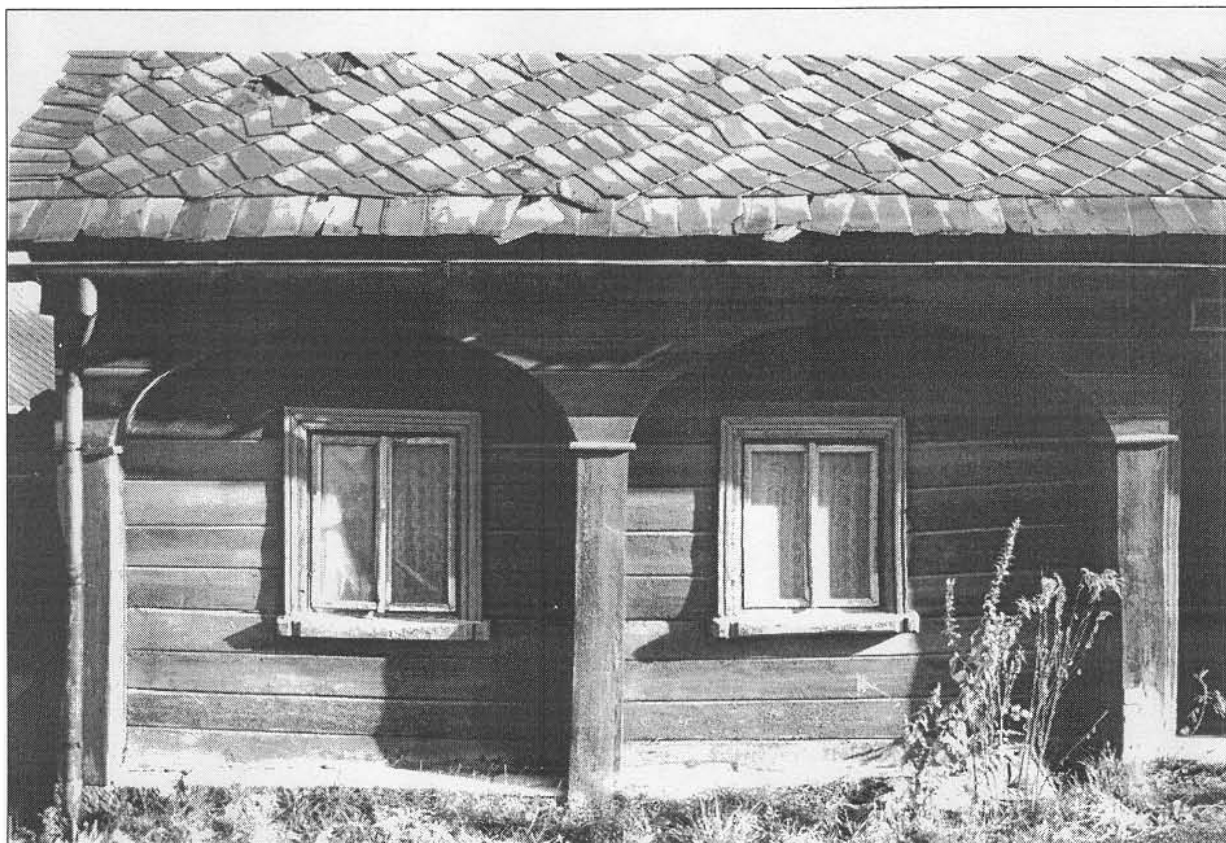
Šluknov č.p. 310 - levý díl domu - uliční průčelí
