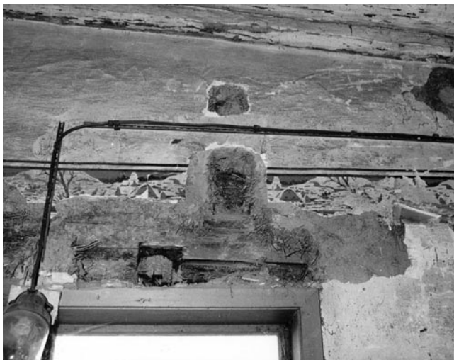
Vračovice čp. 2 (UO) - jizba * 19 - pohled od vstupu * 20 - odkryv mezi okny čelní stěny s ozubem pro osazení zárubně horního větracího okna * 21 - zbytek polenice nad levým oknem do dvora * 22 - sonda ve střední části dvorní stěny * 23 - část zárubně staršího (levého) okna v čelní stěně
