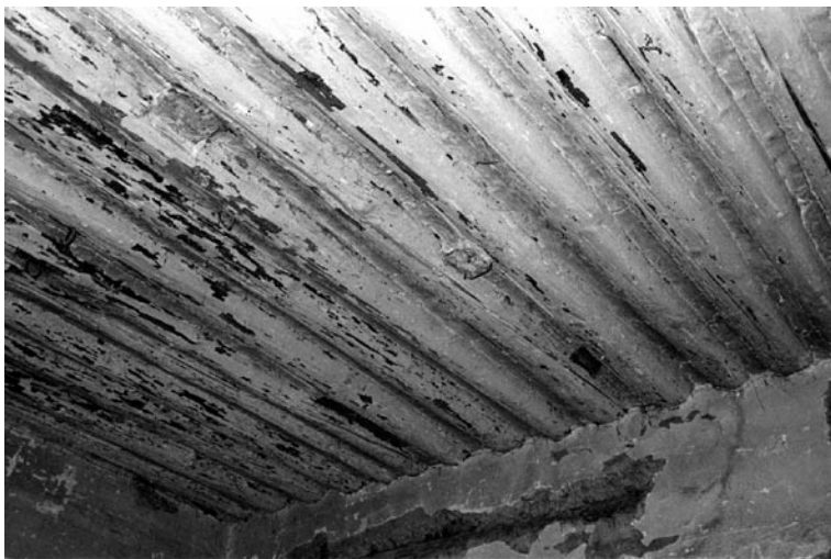
Vračovice čp. 2 (UO) - jizba * 24 - pohled od čela ke vstupu * 25 - odkryv nad vstupními dveřmi * 26 - povaly stropu nad koutem bývalého topeniště s odřezanými zbytky trámkových stojek * 27- horní síň - po pravé straně odkryv větracího otvoru v horní části stěny jizby
