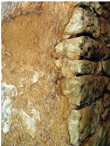
Čistá u Litomyšle čp. 186 (SY) - * 153 - roubené nároží světnice * 154 - točnicové dveře horní komory * 155 - vstup ze síně do dolní spižní komory * 156 - kamenné zdivo s hliněnou omítkou na zadním průčelí * 158 - 159 -160 - detaily koruny zdiva s tesařskými zarážkami
