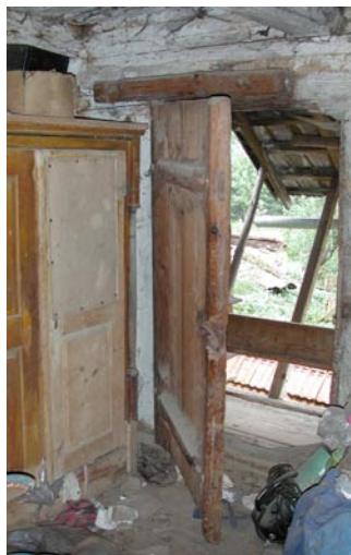
Čistá u Litomyšle čp. 97 (SY) - podjezdná sýpka usedlosti dendrochronologicky datovaná 1709 * 168 - pohled z cesty * 169 - sedlový portál zadní komory * 171 - vložená příčka mezi komorami * 172 - 173 - točnicové dveře komor
