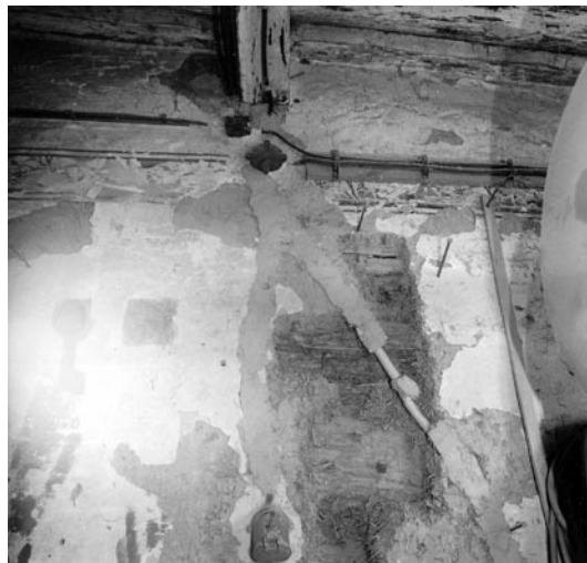
Vračovice čp. 2 (UO) - jizba * 19 - pohled od vstupu * 20 - odkryv mezi okny čelní stěny s ozubem pro osazení zárubně horního větracího okna * 21 - zbytek polenice nad levým oknem do dvora * 22 - sonda ve střední části dvorní stěny * 23 - část zárubně staršího (levého) okna v čelní stěně
