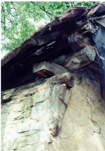
Čistá u Litomyšle čp. 186 (SY) - * 153 - roubené nároží světnice * 154 - točnicové dveře horní komory * 155 - vstup ze síně do dolní spižní komory * 156 - kamenné zdivo s hliněnou omítkou na zadním průčelí * 158 - 159 -160 - detaily koruny zdiva s tesařskými zarážkami
