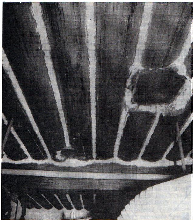
Obr. 5. Povalový základ stropu nad topeništěm v pobledu ke štitové stěně. Vpravo větší otvor zřejmě po bývalém dymníku, uprostřed (před stropním trámem) menší otvor po závěsném osvětlovacím krbu
