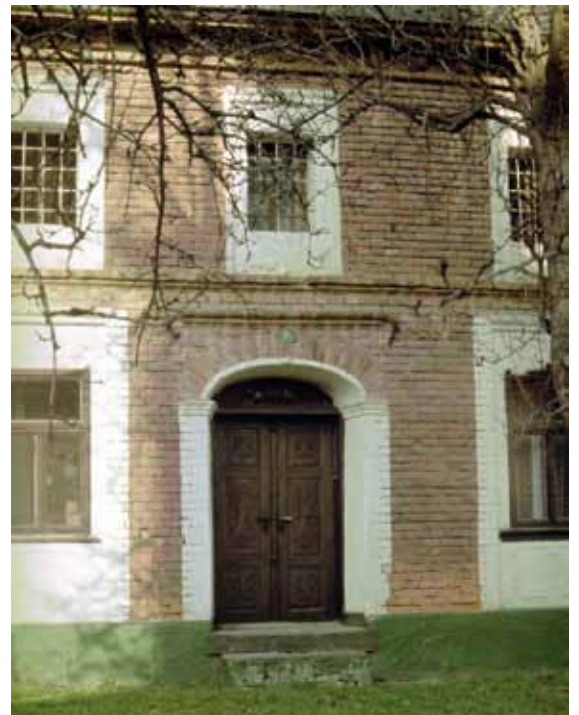
Fig. 22 : Portique avec arcs en briques cuites (bâti vers 1875). Příkazy, distr. Olomouc, Moravie (Z. Syrová).
