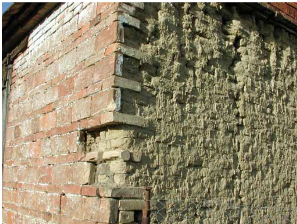
Fig. 24 : Détail d'une façade revêtue en briques cuites de la région de Znojmo (construction vers 1900). Mackovice, distr. Znojmo, Moravie (Z. Syrová).
