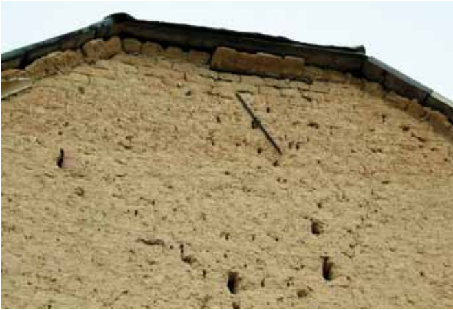
Fig. 19 : Couronnement en briques crues d'un pignon (édification vers 1880). Rataje, distr. Olomouc, Moravie (Z. Syrová).
