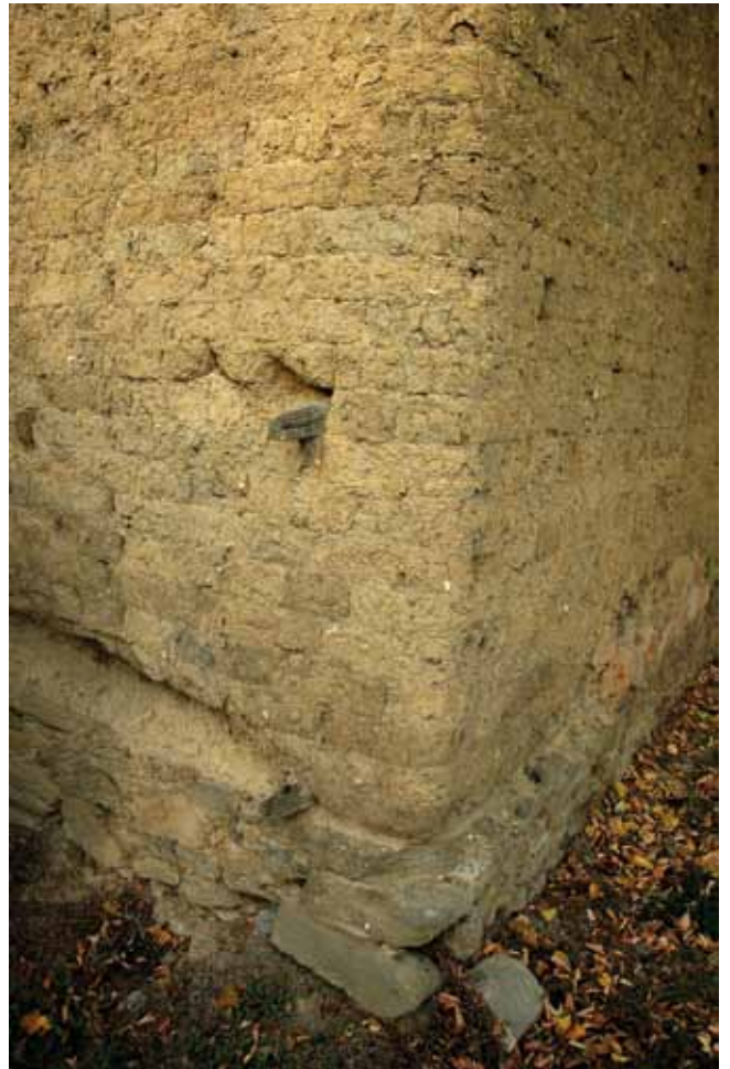
Fig. 13 : Armature en bois à l'angle d'une grange du milieu du XIX e siècle. Rataje, distr. Olomouc, Moravie (Z. Syrová).
