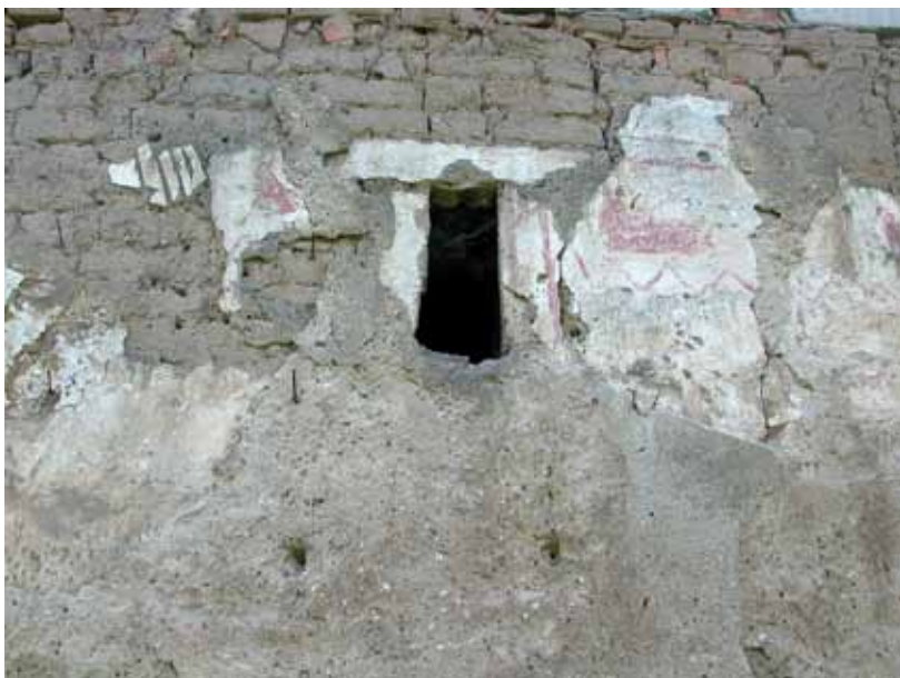
Fig. 3 : Mur en briques crues d'un grenier datant du XV e siècle. Dědibaby, distr. Mělník, Bohême (Z. Syrová).
