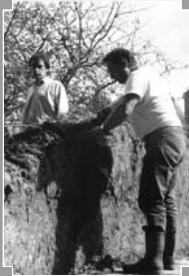
Fig. 4 : Retaille d'une levée de bauge (CAPEB Haute-Normandie).
