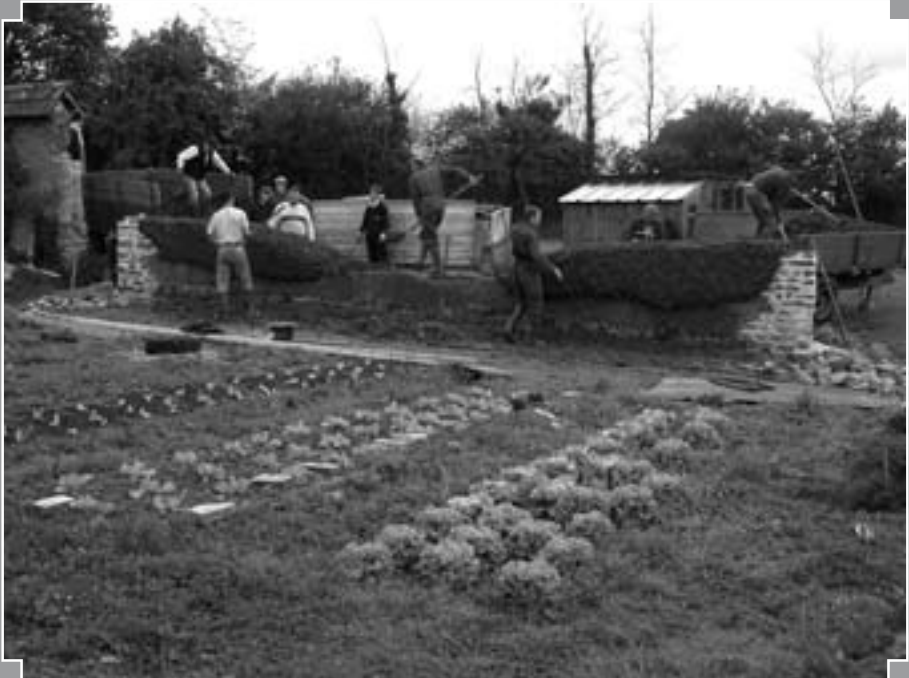
Fig. 6 : Construction d'un mur en bauge - La Chapelle en Juger (A Mainhagu/Pierre et Masse).
