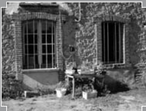
Fig. 6 : Ouvertures en briques sur une longère en bauge à Montauban de Bretagne (V. Guernion).
