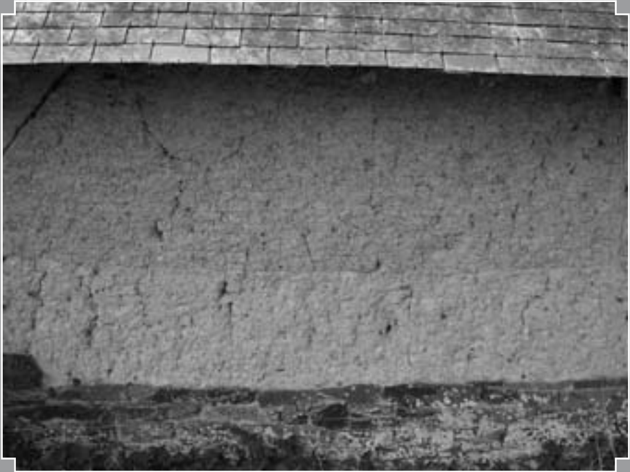
Fig. 5 : Mur en gazons d'argile - Saint Denis le Vêtu (D. Eve/Pierre et Masse).
