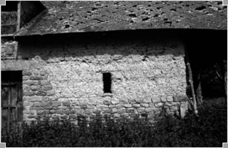
Fig. 4 : Mixité des techniques à Estry, bauges et gazon dans un même bâtiment (Service d'Archéologie du Conseil général du Calvados).
