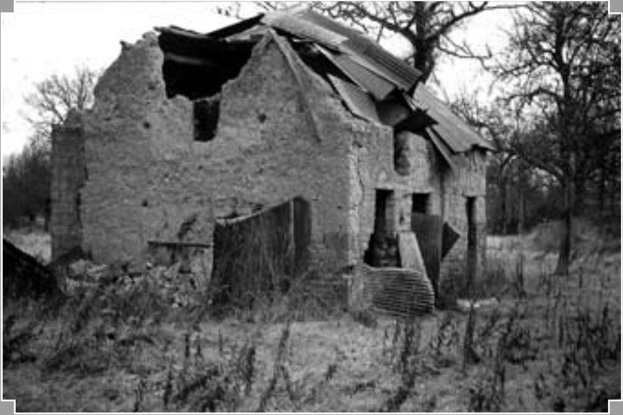
Fig. 8 : Bâtiment en ruine au Theil-Bocage (Service d'Archéologie du Conseil général du Calvados).
