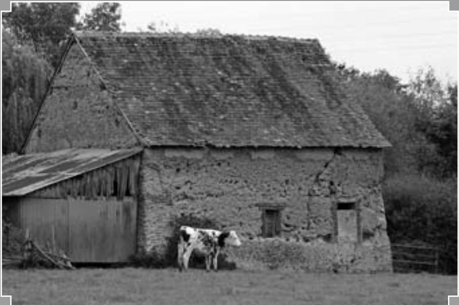
Fig. 4 : Grange au Tertre à Vibraye (PAH du Perche sarthois).
