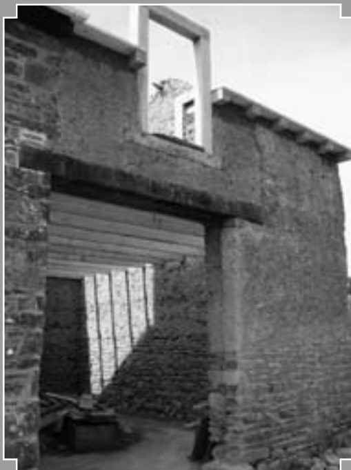
Fig. 5 : Grange après restauration, Maunon (V. Guernion).
