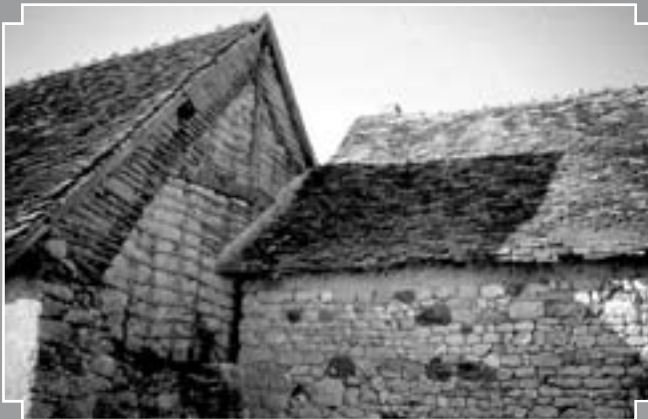
Fig. 6 : Bauge utilisée en pignon sur lattis. A côté elle est utilisée en sommet de mur, Le Peu, Tilly (Dany Chiappero / Pnr Brenne).
