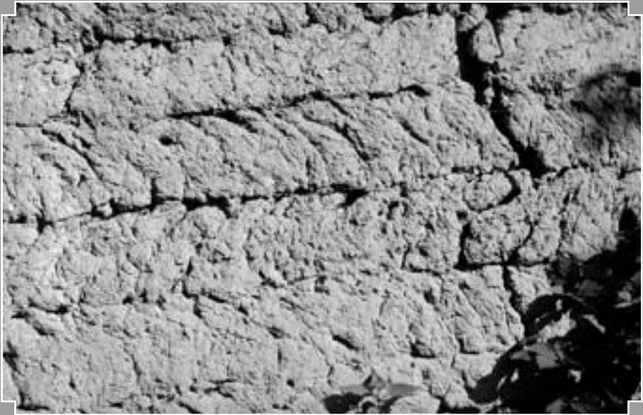
Fig. 5 : Mur de clôture en války hroudové (mottes de terre banchées) à Modrá, distr. Uherské Hradiště (Z. Syrová 1987).
