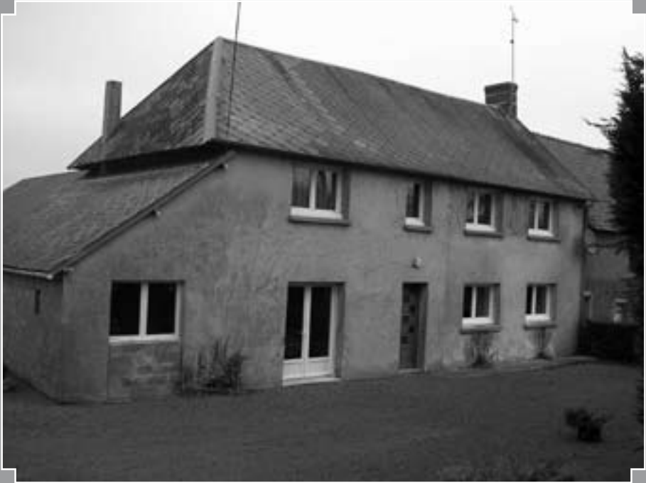
Fig. 1 : Maison en pierre et bauge recouverte en ciment-ouvertures disproportionnées (D. Eve/ Pierre et Masse).
