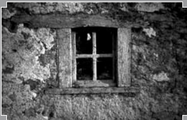
Fig. 8 : La plupart des encadrements sont encore en chêne. Ici la bauge a été recouverte d'un enduit à la chaux, alors que dans la majeure partie des bâtiments on voit peu de traces d'enduits anciens. C'est sans doute dû à un état de dégradation qu'on a voulu corriger grâce à un enduit et non à un enduit posé à l'origine, Le Peu, Tilly (Dany Chiappero / Pnr Brenne).
