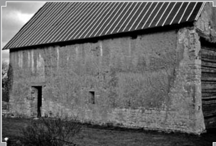
Fig. 2 : Grange en bauge à La Cambe dans le nord du Bessin. Le soubassement en pierres témoigne de l'environnement géologique marno-calcaire (Service d'Archéologie du Conseil général du Calvados).
