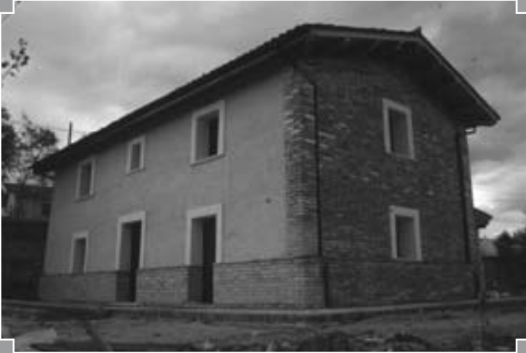
Fig. 5 : casa D'Orazio a Casalincontro prima e dopo il restauro (Associazione Terrae onlus).
