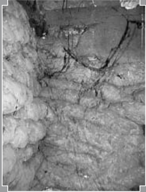
Fig. 8 : Vue int rieure d'un « burget » (armoire « construite » sous un escalier). La partie sup rieure a  t  ferm e   l'aide de pain de terre. La vue int rieure permet de s'en faire une id e particuli rement authentique (G. Bavay).
