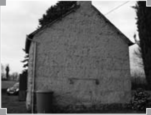
Fig. 9 : Trous rebouchés au mortier terre paille. St Domineuc (V. Guernion).
