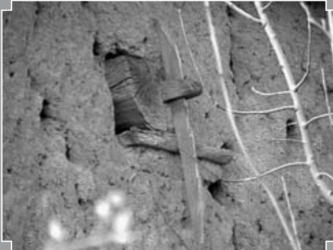
Fig. 2 : Grange du Lombiau. La bauge est la partie la plus spectaculaire d'une formule architecturale englobant un ensemble de dispositifs dont les ancrages (G. Bavay).
