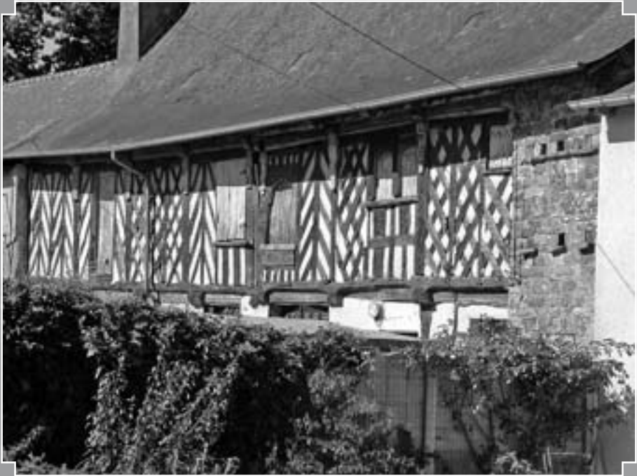
Fig. 5 : Maison du Feuil à Melesse (35) – façade sud - vers 1550 pour la partie à droite, vers 1580 pour la partie gauche, dont la façade arrière est construite en bauge (Ph. Bardel).
