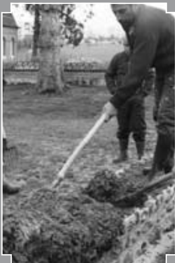
Fig. 1 : Mise en œuvre d'une levée de bauge sur un solin de pierre (CAPEB Haute-Normandie).
