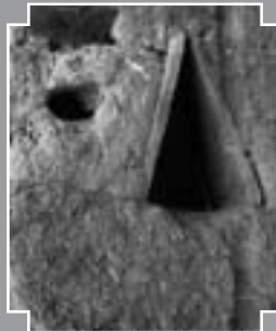
Fig. 6 : Détail de mise en œuvre : aération à Peyremal, Sainte-Livrade-sur-Lot (M. Dubau/SRI Aquitaine).
