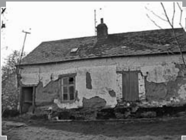
Fig. 4 : Habitation au village de Hoves. L'allure générale ne diffère pas de celle des habitations contemporaines construites en matériaux durables (G. Bavay).
