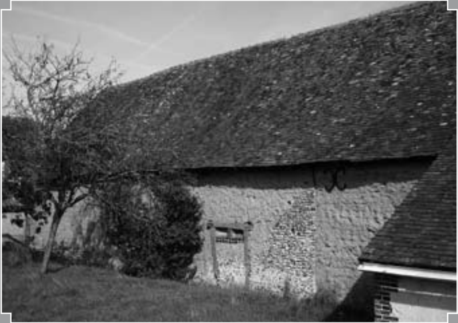
Fig. 7 : Les Pâtis à Préval, façade postérieure (PAH du Perche sarthois).
