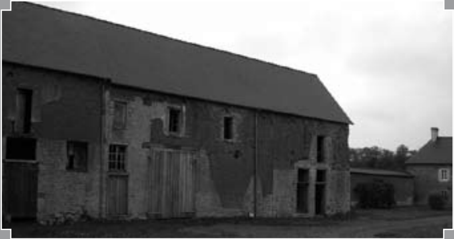
Fig. 9 : Dépendance en bloc-à-terre (19 e siècle) à Colombières (E. Patte / Pnr des Marais du Cotentin et du Bessin).
