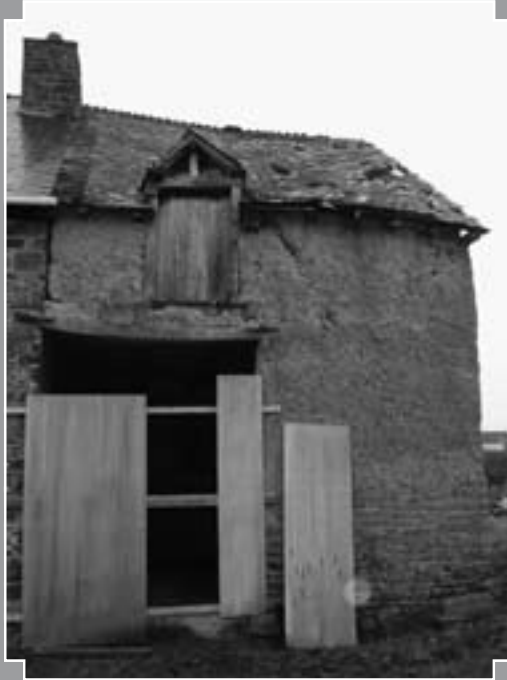
Fig. 3 : Grange en bauge avant intervention à Mauron (V. Guernion).
