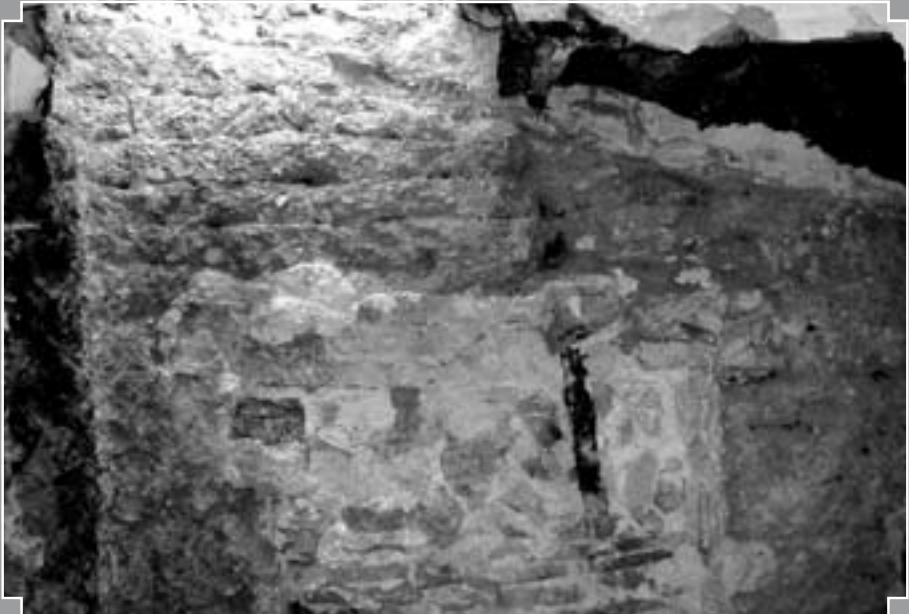
Fig. 10 : Béziers (Hérault) : construction en lits de terre réguliers séparés par des rangs de bruyères, 14 e s. (C.-A. de Chazelles).
