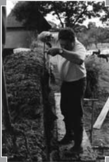
Fig. 3 : Retaille d'une levée de bauge (CAPEB Haute-Normandie).
