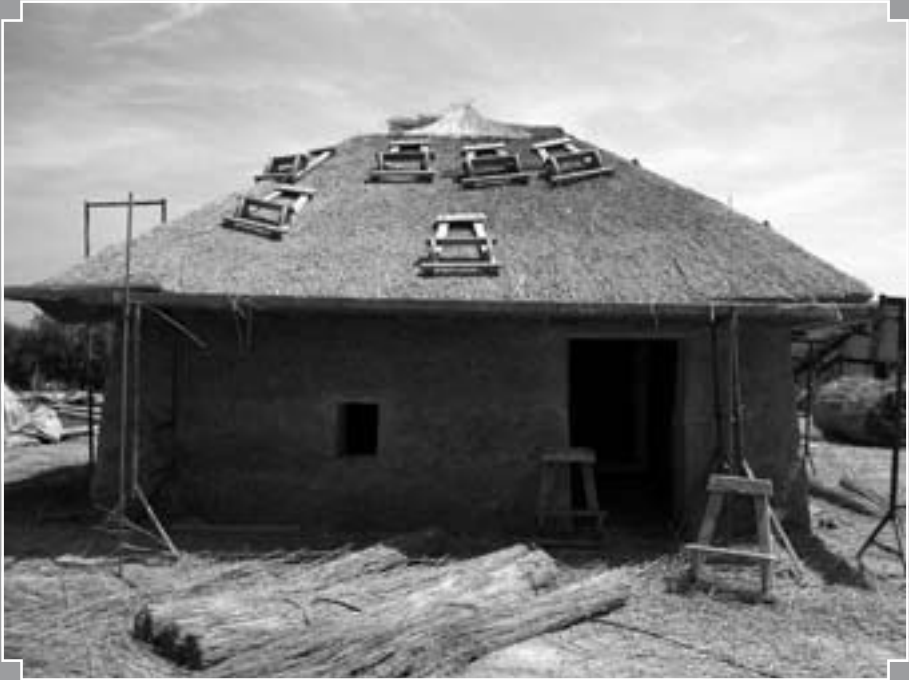
Fig. 9 : Croupe, restauration de la bourrine « Les Blanches » (D. Milcent).
