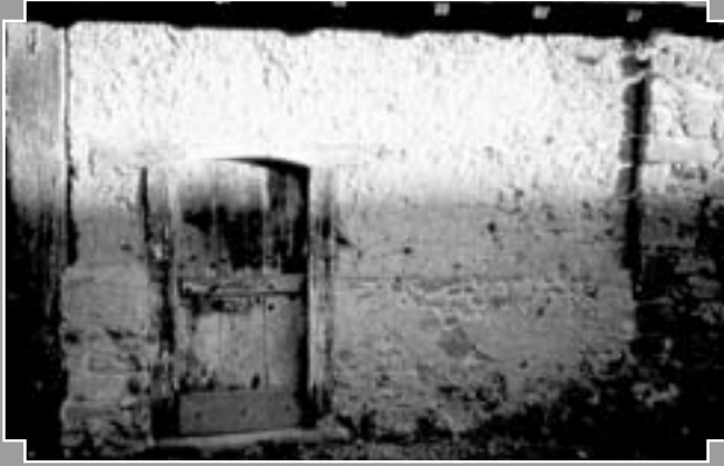
Fig. 3 : Bauge montée sur mur bahut, structure sur poteaux, Le Peu, Tilly (Dany Chiappero / Pnr Brenne).
