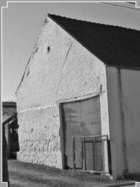
Fig. 5 : Grange au village de Naast. Sous le badi- geon, la grange est rest e « invisible » long- temps. L' eil d couvre aujourd'hui une grange en bau- ge rehauss e en brique tant au pignon que sur les murs lat raux (G. Bavay).
