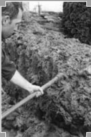
Fig. 2 : Mise en œuvre d'une levée de bauge (CAPEB Haute-Normandie).
