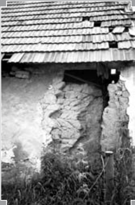
Fig. 10 : Détail du mur en construction mixte en váľky (rouleaux ou mottes de terre) banchés appareillés en épi et briques crues à Pernek, Slovaquie (Z. Syrová 1995).
