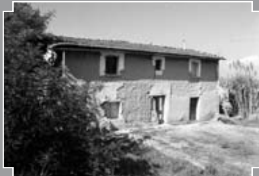
Fig. 4 : casa D'Orazio a Casalcontrada prima e dopo il restauro (Associazione Terrae onlus).
