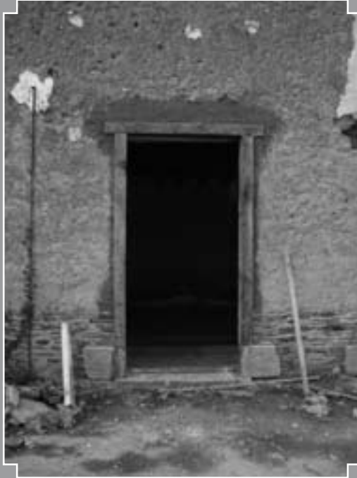
Fig. 7 : Remplacement des briques par une carrée double en chêne (V. Guernion).
