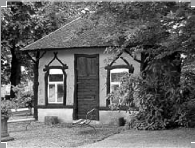
Fig. 7 : Pavillon de jardin du château de la Roche à Thieusies. Derrière un décor «savant» simplement plaqué, toute la structure est typique de l'architecture de bauge. C'est le seul bâtiment portant millésime (1908) et probablement aussi le plus récent (G. Bavay).
