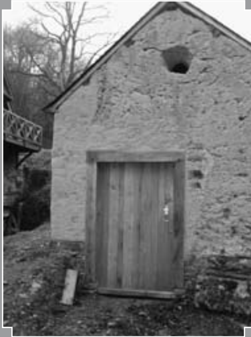
Fig. 1 : Pignon d'un fournil en bauge à Caulnes (V. Guernion).
