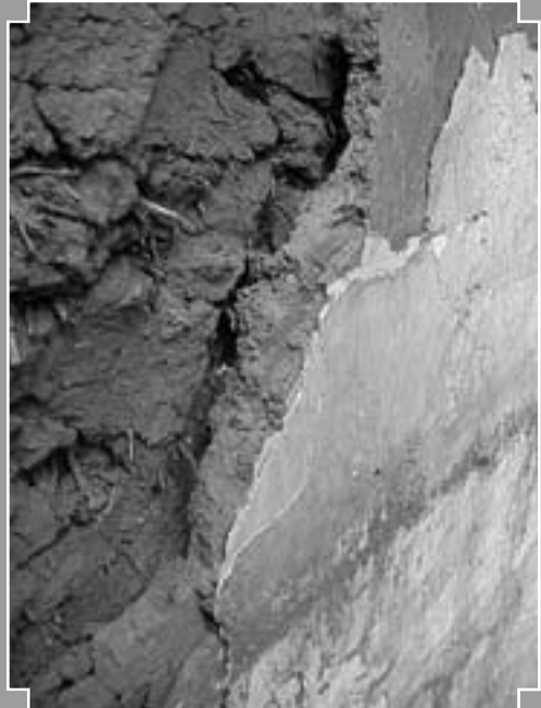
Fig. 9 : D tail des enduits sur la face int rieure d'un mur de terre d'une habitation du village de Bierghes. Sur un support o  l'on distingue la trace des pains de terre et de l'outil utilis  pour les  galiser, deux couches de terre m lang e de fines pailles. La couche sup rieure est tr s soigneusement liss e (G. Bavay).
