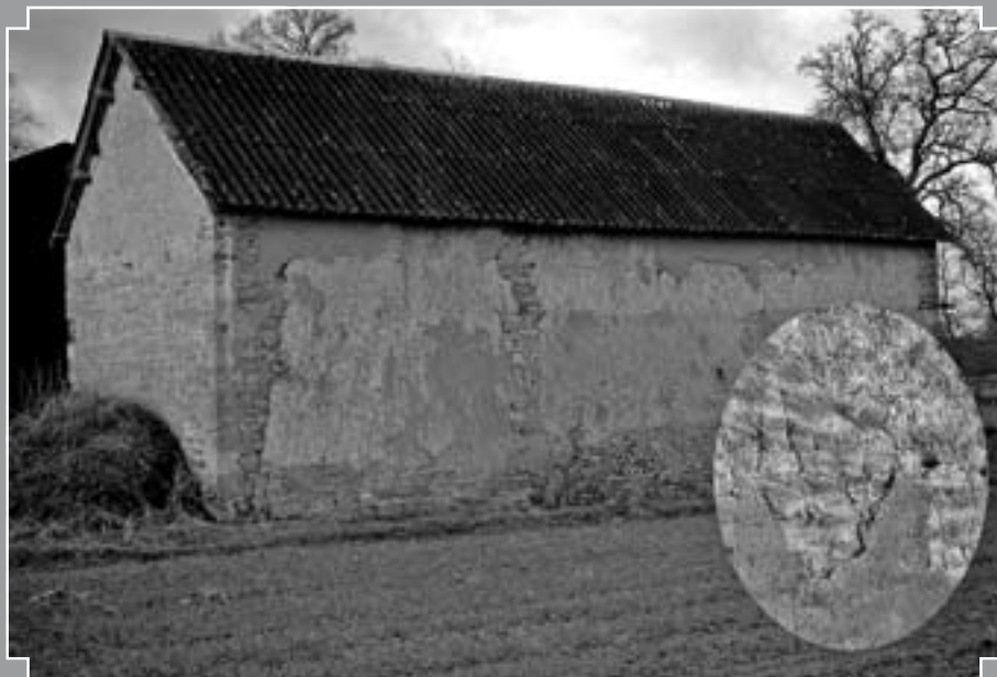
Fig. 6 : Grange à Estry. Les murs enduits à l'origine présentent une fissuration en blocs cubiques (en cartouche) pouvant incriminer une technique de construction proche de l'adobe (Service d'Archéologie du Conseil général du Calvados).
