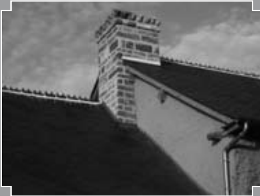
Fig. 10 : Pignon d'une maison en Bauge à Romillé (V. Guernion).
