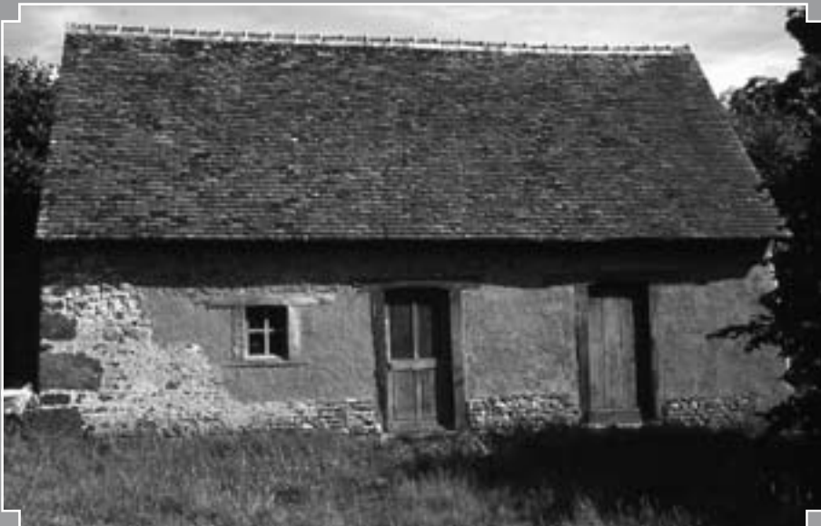
Fig. 4 : Maison « au lierre », construite entièrement en bauges sauf le pignon sur lequel s'appuie la cheminée. Le mur bahut remonte pour former une sorte de berceau aux angles, Le Peu, Tilly (Dany Chiappero / Pnr Brenne).
