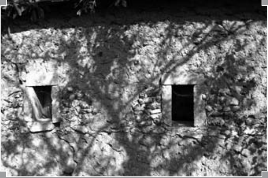
Fig. 9 : Calage des ouvertures aux Pâtis, à Préval (PAH du Perche sarthois).
