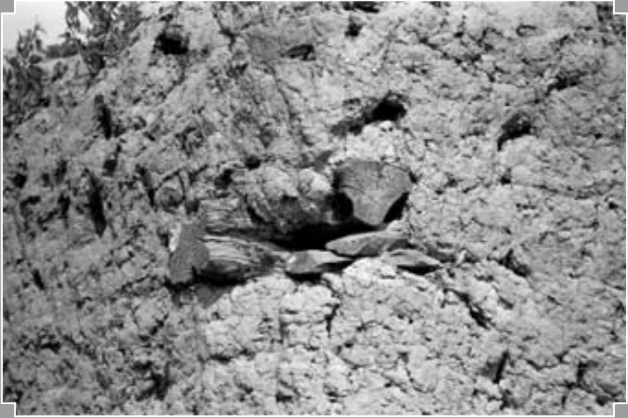
Fig. 9 : Détail de l'armature de l'angle d'une grange en války (rouleaux ou mottes de terre) banchés avec les restes de terre à Hruška, distr. Prostějov (Z. Syrová 2000).
