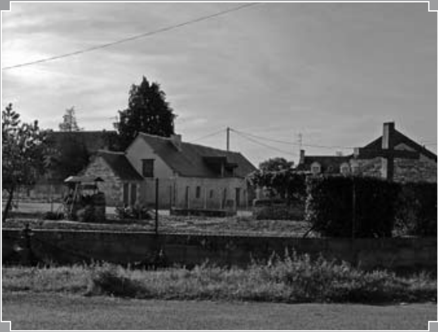
Fig. 8 : Restauration de la Ferme n° 6 (L. Malvido).
