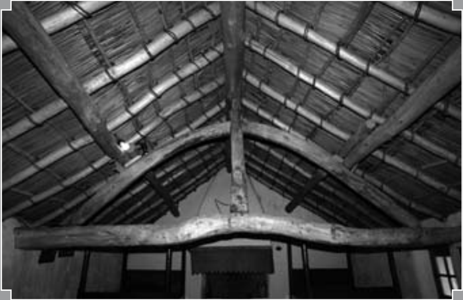
Fig. 7 : Charpente, bourrine à Chartier, Ecomusée du marais Breton Vendéen – Le Daviaud, 2004 (P. Durandet / Conservation Départementale des Musées de Vendée).
