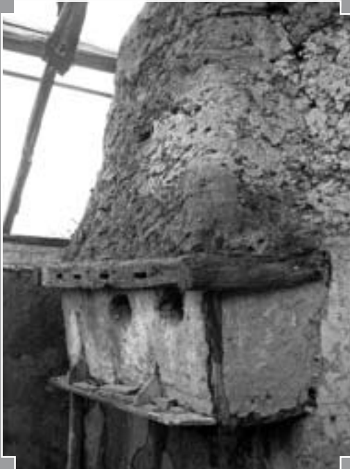
Fig. 10 : Belle-Vue à Vibraye, cheminée en terre - détruite (PAH du Perche sarthois).
