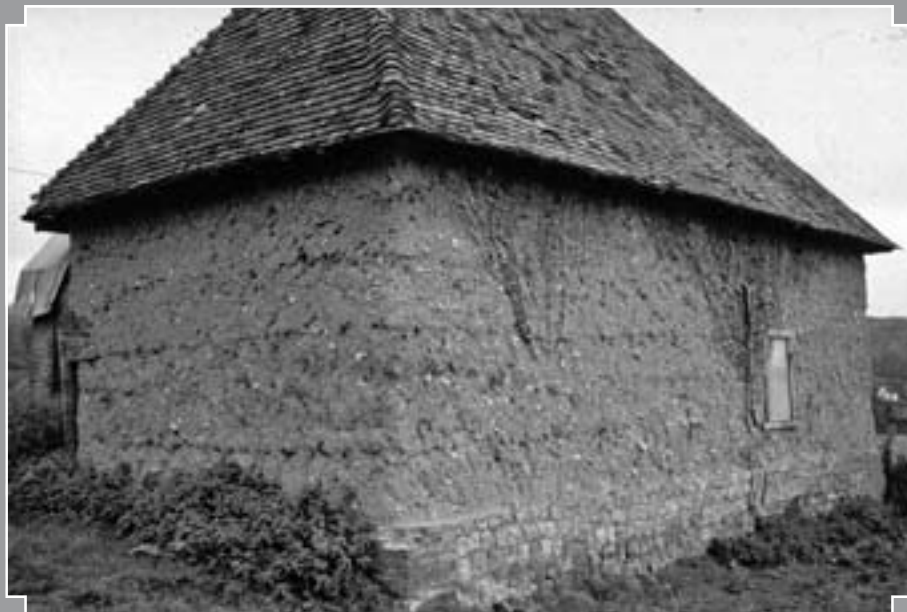
Fig. 7 : Construction en bauge du Pays d'Auge à Hermival-les-Vaux. La terre à bâtir est très grossière et les levées présentent des épaisseurs variables (Service d'Archéologie du Conseil général du Calvados).
