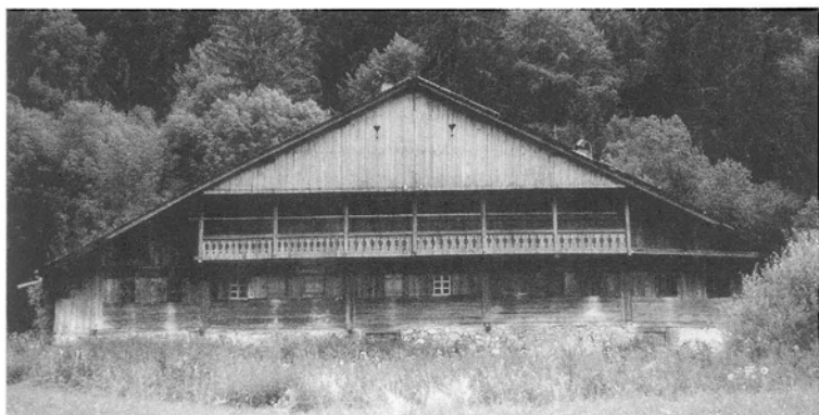
Obr. 11. Abondance, Plan Drozin, čp. 1784, 1785: dům druhotně rozdělený na dvojdům orientovaný obytnou částí do údolí s vročením 1840, 1876(?); původní obytná kuchyně je ve středu dispozice, zcela vpravo druhá kuchyně přistavěná na severním okraji obytné části. Hlavní severovýchodní průčelí. Foto Françoise Very 1995. – Abb. 11. Abondance, Plan Drozin, KNr. 1784, 1785: sekundär in ein Doppelhaus unterteiltes Haus mit dem Wohnbereich zum Tal hin orientiert, mit den Jahresangaben 1840, 1876(?); die ursprüngliche Wohnküche befindet sich in der Mitte des Grundrisses, ganz rechts die zweite, an den Nordrand des Wohnbereichs angebaute Küche. Nordöstliche Hauptfassade. Foto Françoise Very 1995.
