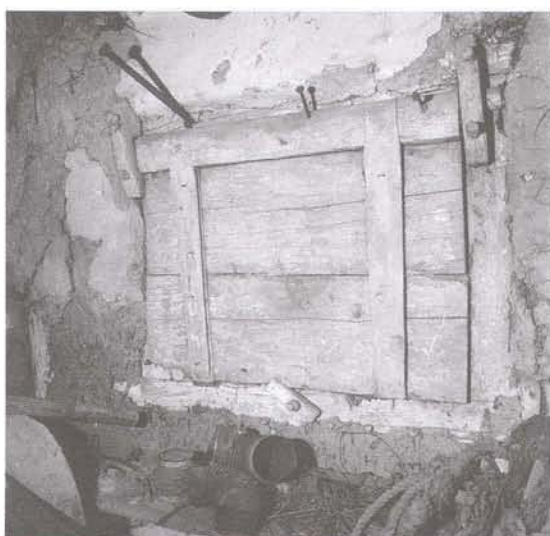
Obr. 19. Rychnov na Moravě čp. 137, dům usedlosti. Pohled ze síně na točnicovou okenici. Foto J. Škabrada, 1992. – Abb. 19. Rychnov in Mähren KNr. 137, Haus des Anwesens. Blick aus der Halle auf einen Angelpfosten-Fensterladen. Foto J. Škabrada, 1992.
