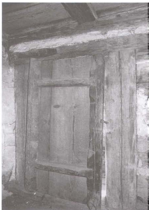
Obr. 14. Čistá u Litomyšle čp. 171, dům usedlosti. Rubová straně točnicových dveří z horní síně na někdejší pavlač. Foto J. Škabrada, 1997. – Abb. 14. Čistá bei Litomyšl KNr. 171, Haus des Anwesens. Rückseite der Angelpfostentür der oberen Halle zum ehemaligen Laubengang. Foto J. Škabrada, 1997.
