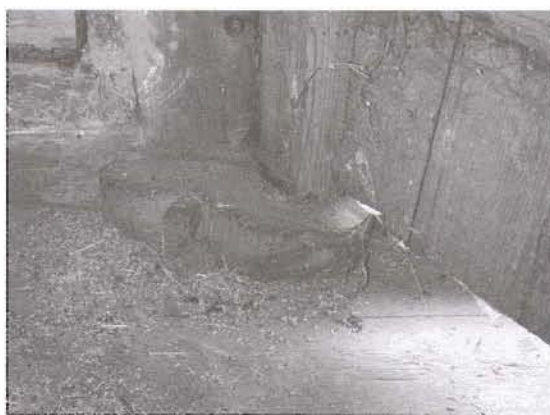
Obr. 18. Trstěnice čp. 123, podjezdná sýpka usedlosti. Dolní oko uchycení točnicových dveří. Foto Z. Syrová, 2003. – Abb. 18. Trstěnice KNr. 123, Einfahrtsspeicher des Anwesens. Untere Öse der Verankerung der Angelpfostentür. Foto Syrová, 2001.
