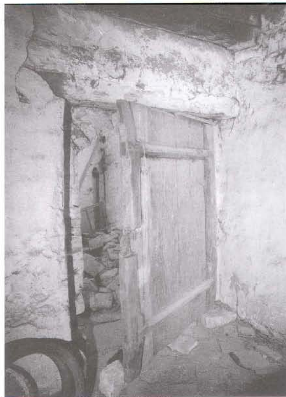
Obr. 7. Cerekvice nad Loučnou čp. 11, dům usedlosti. Rubová strana točnicových dveří horní komory. Foto J. Škabrada 2000. – Abb. 7. Cerekvice nad Loučnou KNr. 11, Haus des Anwesens. Rückseite der Angelpfostentür der oberen Kammer. Foto J. Škabrada, 2000.
