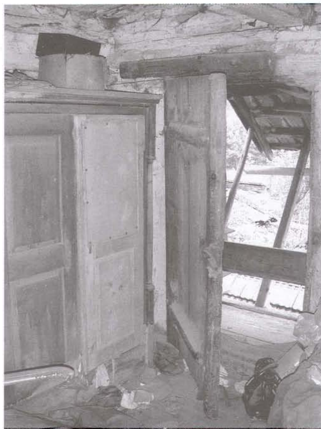
Obr. 16. Čistá u Litomyšle čp. 171, dům usedlosti. Pohled ze dvora na stěnu horní síně s větracím otvorem a portálem na pavlač. Foto Z. Syrová, 2003. – Abb. 16. Čistá bei Litomyšl KNr. 171, Haus des Anwesens. Blick vom Hof auf die Wand der oberen Halle mit Lüftungsöffnung und Portal auf den Laubengang. Foto Syrová, 2003.
