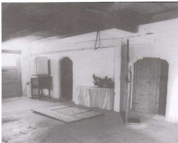
Obr. 5. Trstěnice čp. 61, dům usedlosti. Pohled ze síně na dvojici archaických sedlových portálů komor. Foto J. Škabrada, 1989. – Abb. 5. Trstěnice KNr. 11, Haus des Anwesens. Blick von der Halle auf ein Paar archaischer Schulterbogenportale der Kammern. Foto J. Škabrada, 1989.
