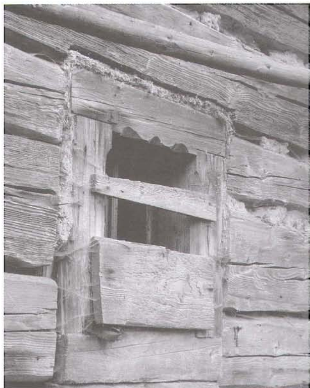
Obr. 3. Čistá u Litomyšle čp. 97, výměnek usedlosti. Detail zdobené zárubně okna v čelní stěně světnice. Foto J. Škabrada, 2001. – Abb. 3. Čistá bei Litomyšl KNr. 97, Altenteil des Anwesens. Detail der verzierten Zarge des Fensters in der Giebelwand der Stube. Foto J. Škabrada, 2001.
