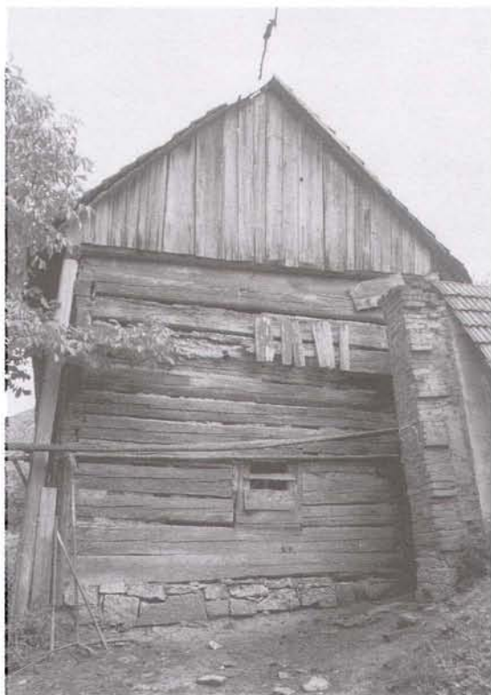
Obr. 2. Čistá u Litomyšle čp. 97, výměnek usedlosti. Pohled na štítové průčelí. Foto Z. Syrová, 2001. – Abb. 2. Čistá bei Litomyš KNr. 97, Altenteil des Anwesens. Ansicht der Giebfassade. Foto Z. Syrová, 2001.
