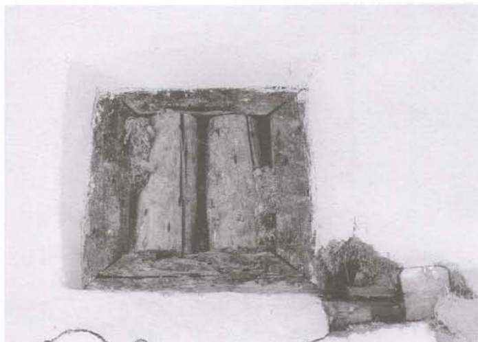
Obr. 1. Čistá u Litomyšle čp. 171, dům usedlosti. Detail odkryté trámkové zárubně horního větracího okna dymné jizby. Foto J. Škabrada, 2000. – Abb. 1. Čistá bei Litomyšl KNr. 171, Haus des Anwesens. Detail der freigelegten Balkenzarge des oberen Lüftungsfensters der Rauchkammer. Foto J. Škabrada, 2000.
