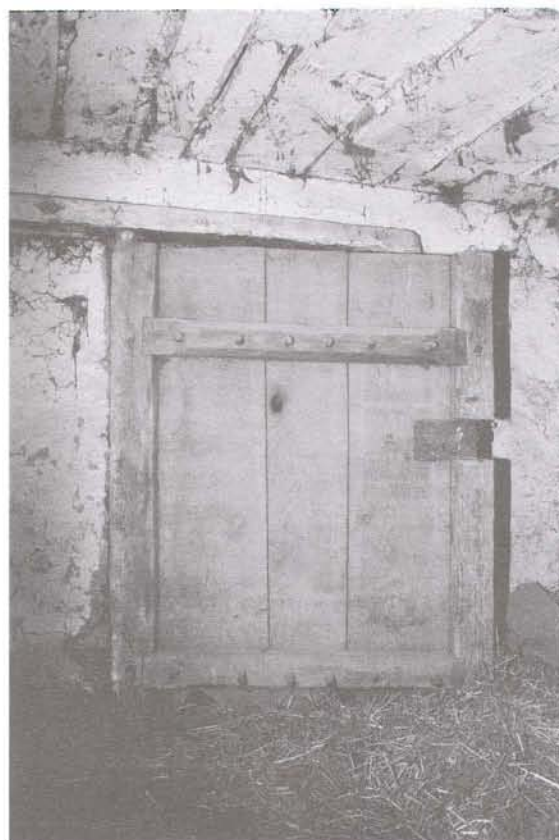
Obr. 12. Vraclav čp. 49. Pohled na rubovou stranu točnicových dveří horní komory. Foto J. Škabrada, 1989. – Abb. 12. Vraclav KNr. 49, Rückseite der Angelpfostentür der oberen Kammer. Foto J. Škabrada, 1989.
