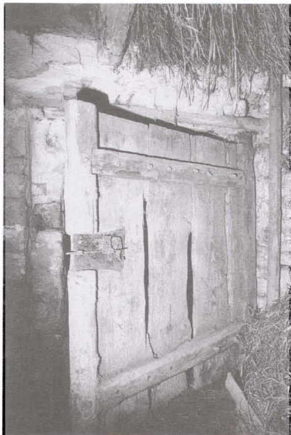
Obr. 10. Vraclav čp. 49. Pohled na rubovou stranu točnicových dveří dolní komory. Foto J. Škabrada, 1989. – Abb. 10. Vraclav KNr. 49, Rückseite der Angelpfostentür der unteren Kammer. Foto J. Škabrada, 1989.
