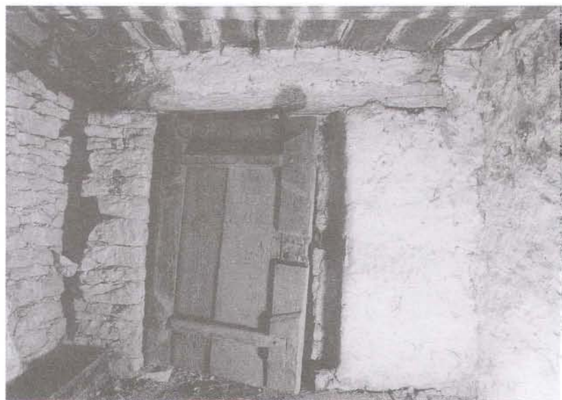
Obr. 13. Čistá u Litomyšle čp. 186, dům usedlosti. Rubová strana točnicových dveří dolní komory. Foto J. Škabrada, 2000. – Abb. 13. Čistá bei Litomyšl KNr. 186, Haus des Anwesens. Rückseite der Angelpfostentür der unteren Kammer. Foto J. Škabrada, 2000.
