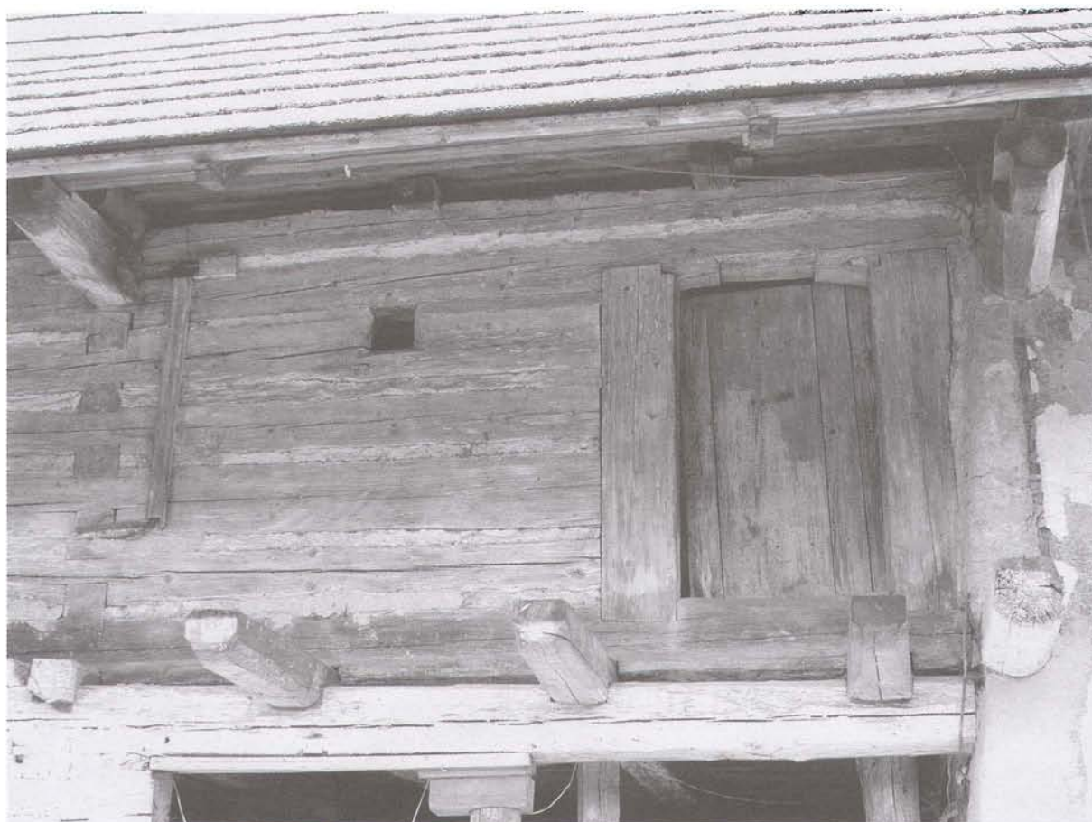
Obr. 16. Čistá u Litomyšle čp. 171, dům usedlosti. Pohled ze dvora na stěnu horní síně s větracím otvorem a portálem na pavlač. Foto Z. Syrová, 2003. – Abb. 16. Čistá bei Litomyšl KNr. 171, Haus des Anwesens. Blick vom Hof auf die Wand der oberen Halle mit Lüftungsöffnung und Portal auf den Laubengang. Foto Syrová, 2003.
